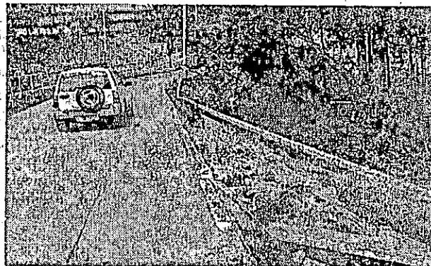
Estructura de la vía y andén en buenas condiciones - muro de cerramiento fallado
