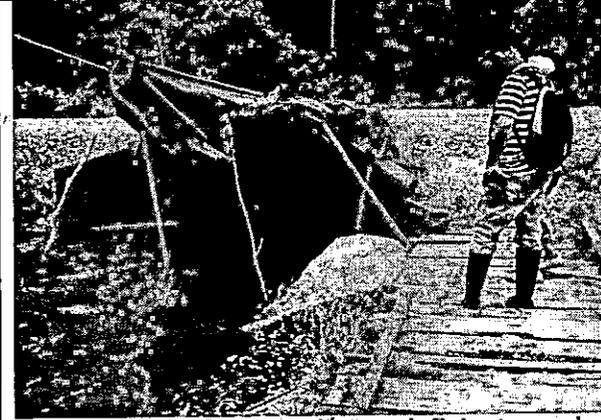
Foto 10. Construcción deficiente de alcantarillas en la intervención de cauces
