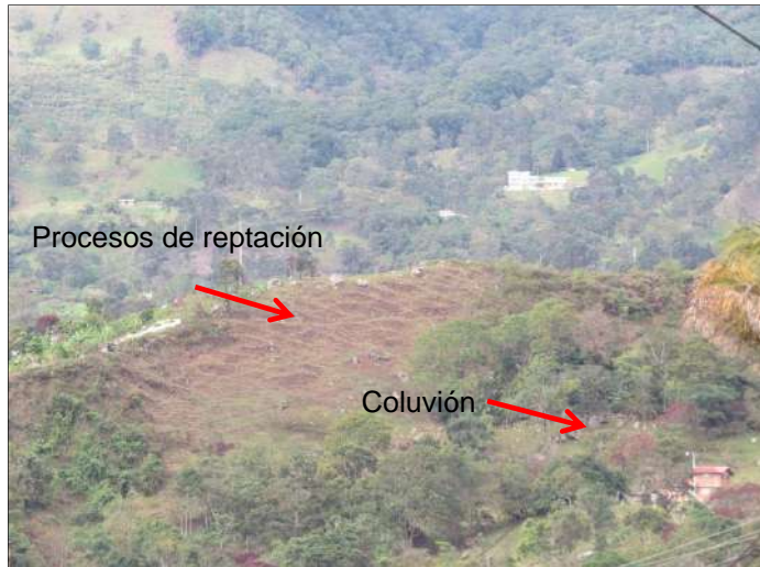
FIGURA 4-4 PROCESOS DE REPATCIÓN Y CAÍDA DE BLOQUES.
