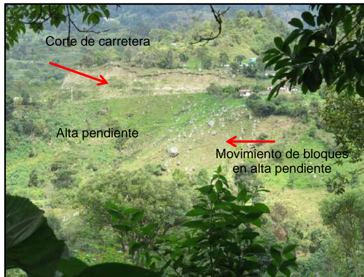
FIGURA 4-6 CORTE DE CARRETERA, MOVIMIENTO DE BLOQUES
