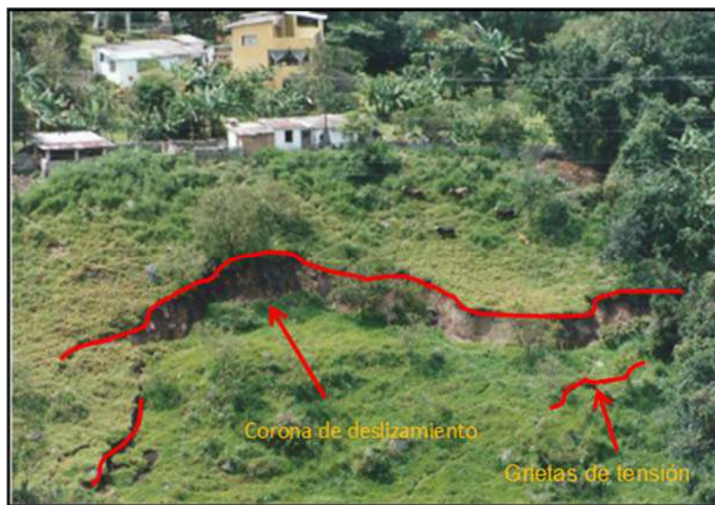
FIGURA 4-8 Corona de deslizamiento y grietas de tensión
