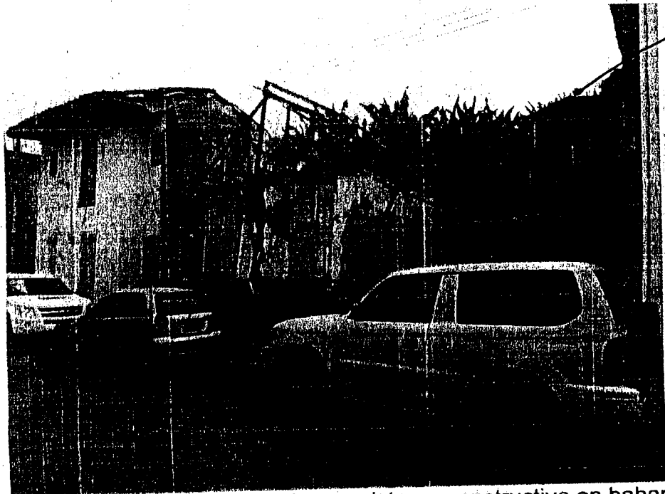
Imagen 2. Alto deterioro en paredes en sistema constructivo en bahareque.
