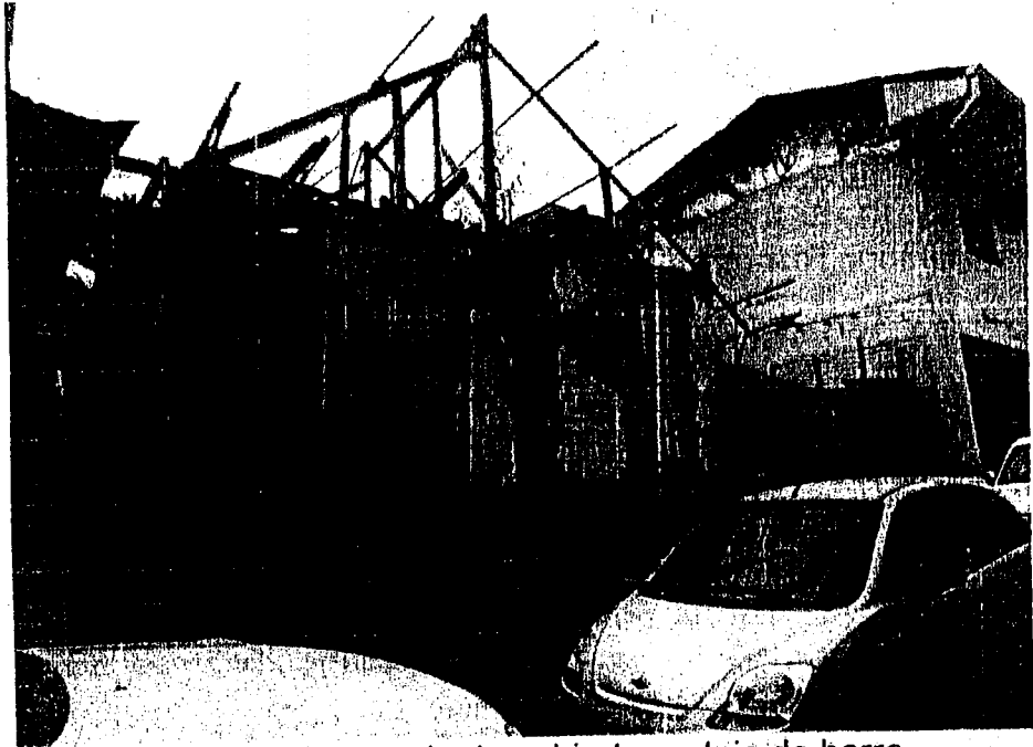
Imagen 1. Ausencia de cubierta en teja de barro.
