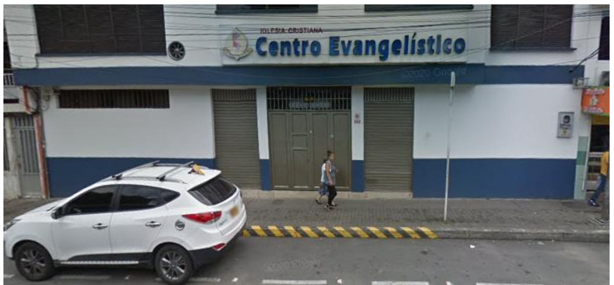
Fotografía del local, sin rampa, para acceso universal.
