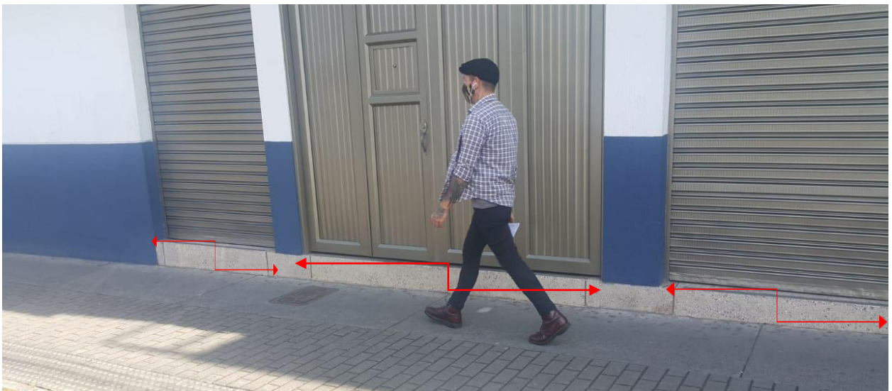
Ubicación del sitio de vulneración, especialmente de los accesos, con barreras de accesibilidad.
