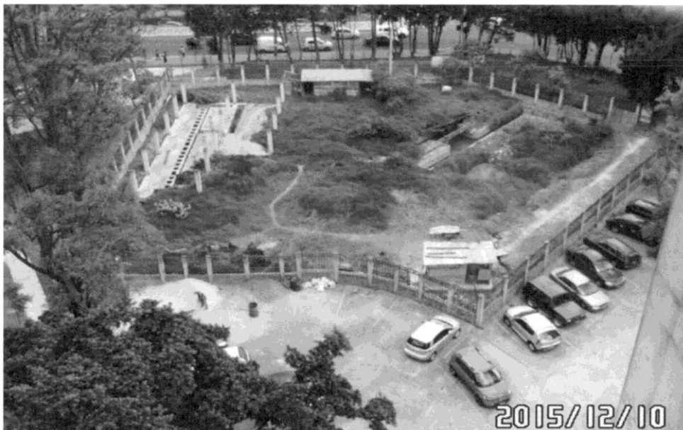
PROCESO No. 2011-0407.- FOTO No. 1.- SE APRECIA EL NUEVO CERRAMIENTO DEL ÁREA TOTAL EN POSESION DE CODENSA S. A. ESP. Y EL ESTADO DE LA OBRA EN LA SUBESTACIÓN CUAN DE 115 KV. SE MUESTRAN TAMBIEN LAS ZONAS DE PARQUEADERO, DEMARCADAS CON LINEAS AMARILLAS Y EN SU MAYORÍA OCUPADAS.
