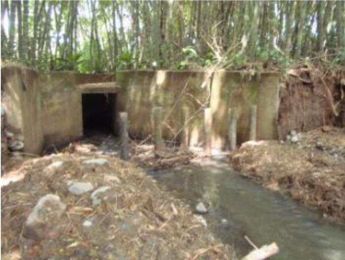
*Posteriormente, se realizó monitoreo en algunas cajas y cámaras de inspección (respiraderos), hasta llegar al descole final, donde se aprecia el normal flujo de aguas y no se evidencian represamientos, los cuales se describen a continuación:*
