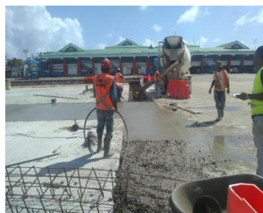
TERMINACIÓN FUNDIDA DE LOSAS SEGUNDA MITAD DE FASE 5B
