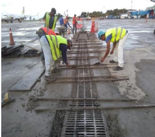
FUNDIDA CANAL 1 FRENTE A BOMBEROS ENTRE FASES 1 Y 2
