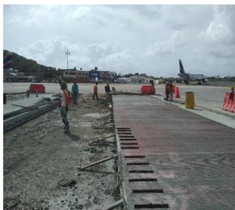
FUNDIDA DE LOSAS SEGUNDA MITAD DE FASE 5B
