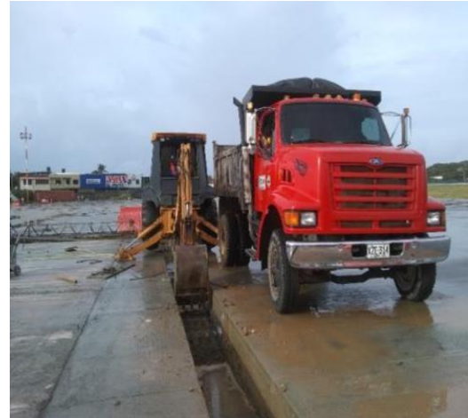
EXCAVACIÓN CANAL 6 TRAMO DE LA SEGUNDA MITAD DE LA FASE 5B
