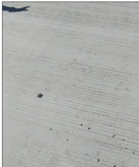
Microfisuración por agentes climáticos
