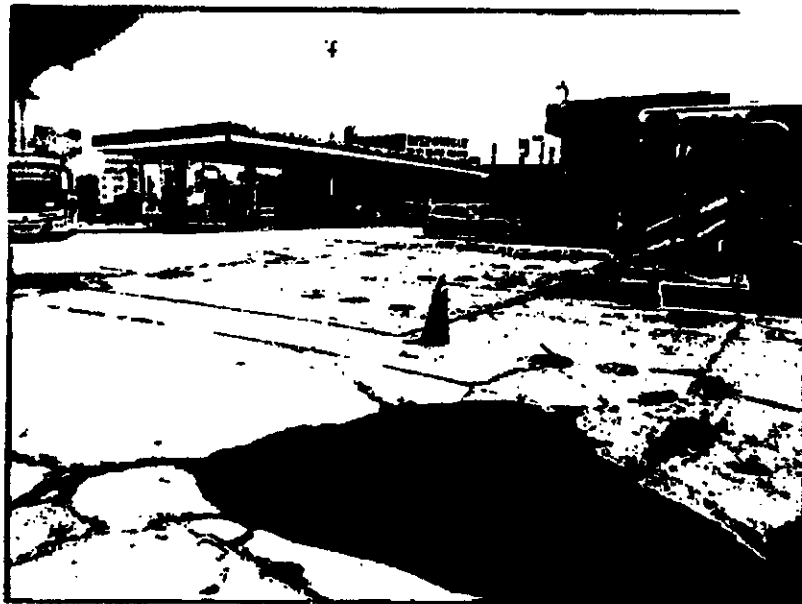
Vista de salida de la Bomba la Amparo hacia la Troncal de Occidente
