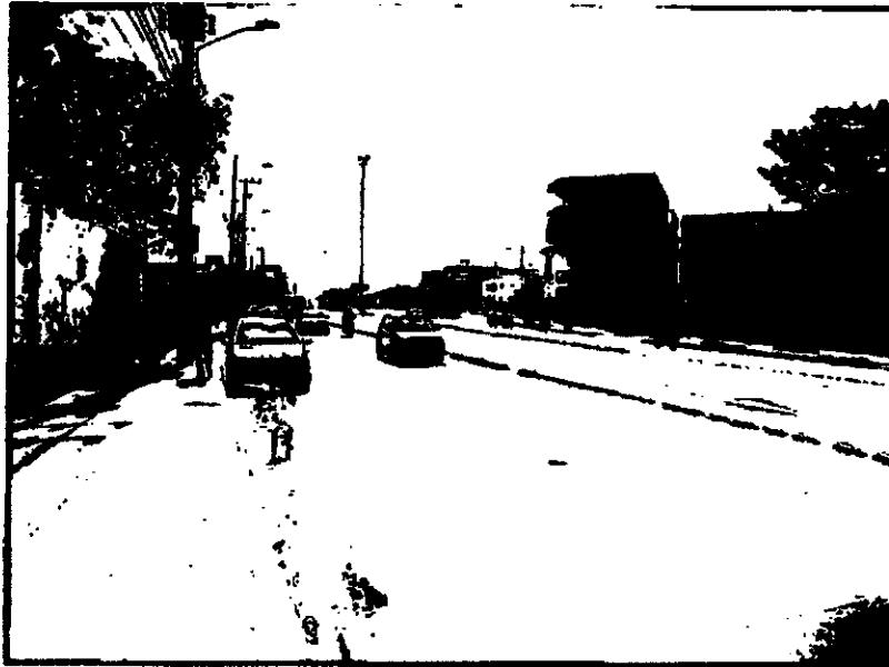
Vista carril mixto salida de la cordialidad hacia la estación el Gallo
