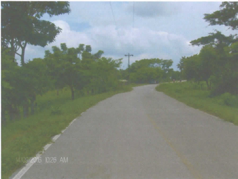
Curva de la vía Margarita-Hatillo de Loba, entre el Botón y Sandoval; en el sentido Hatillo de Loba. El sector angosto en la vía corresponde al puente, tiene menos ancho que la vía, como puede observarse fácilmente. El puente está localizado en el centro de la curva
