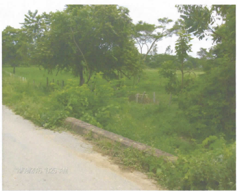
El otro Bordillo del puente o pontón, en concreto rígido
