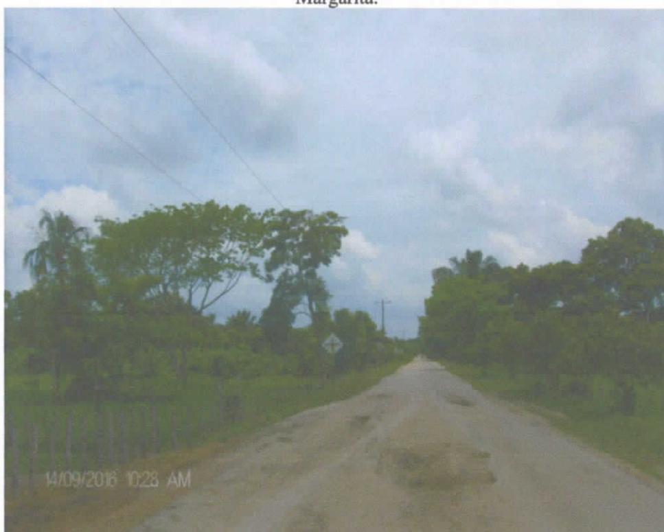
Tramo de la vía Mompox – Hatillo de Loba. En sentido a Mompox. A la izquierda señales de tránsito.
