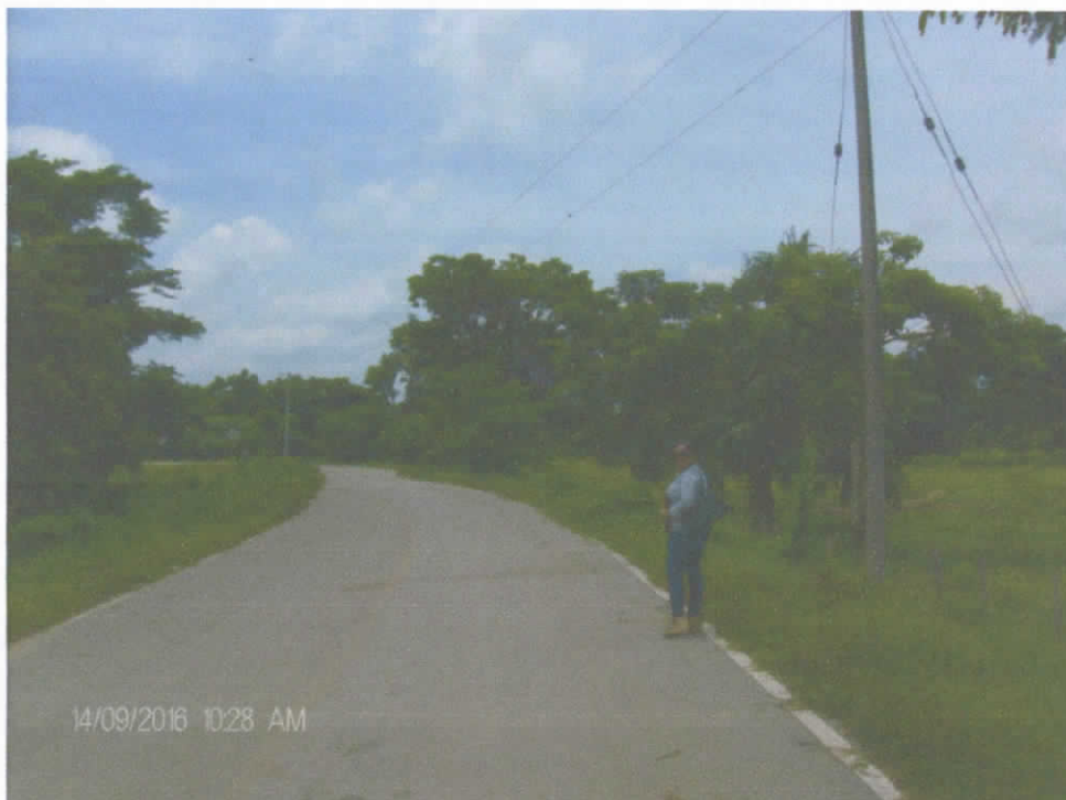
Curva de la vía Margarita-Hatillo de Loba, entre el Botón y Sandoval; en el sentido Hatillo de Loba. Se observan el sector angosto donde se encuentra el puente, Los avisos con las señales de tránsito, y a la derecha, la juez del juzgado de Margarita.
