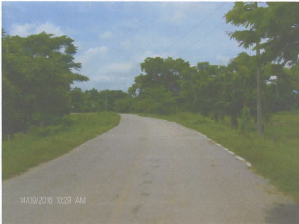
Tramo de la vía Margarita-Hatillo de Loba, entre el Botón y Sandoval; muy cerca del puente. La pendiente en todo este tramo de la vía es pequeña, suave como puede observarse.
