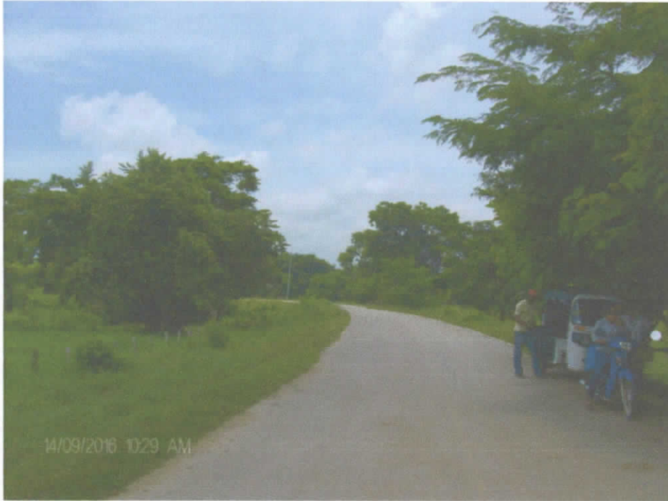
Tramo de la vía Margarita-Hatillo de Loba, entre el Botón y Sandoval; muy cerca del sitio donde ocurrió el suceso calamitoso. Se observa la pendiente suave o pequeña que tiene la vía hacia a la izquierda.
