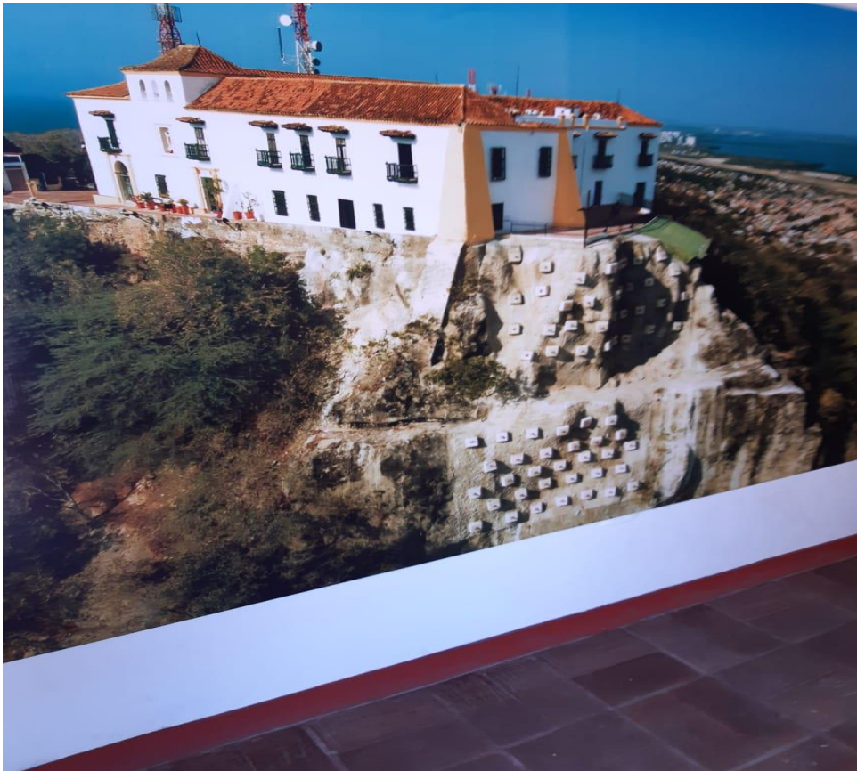
Foto N°1: Vista panorámica de la parte del Salto del Cabrón estabilizada con los Tensores con cables de acero que se incrustaron a cierta profundidad para evitar Que se derrumbe el santuario de Nuestra Señora de La Candelaria, en La Popa.
