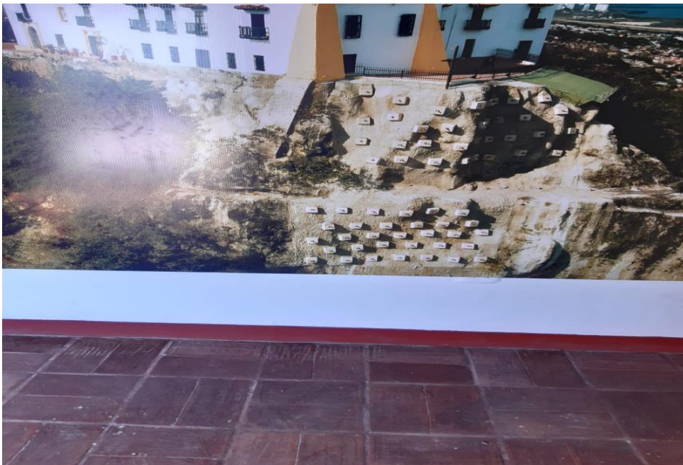
Foto N°2: Otra vista del Salto del Cabrón, donde se aprecian los cabezotes De concreto armado de los anclajes atirantados.
