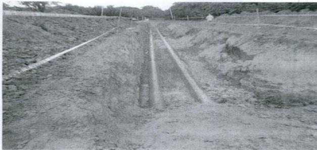
Excavación dentro del Predio Perico para tubería nueva de Ecopetrol
