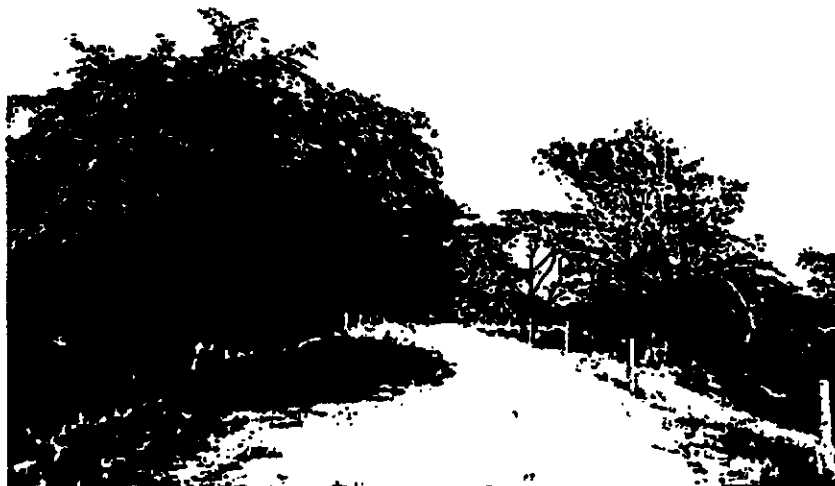
VIA DE ACCESO CARRETEABLE CALAMAR-SAN CRISTOBAL
