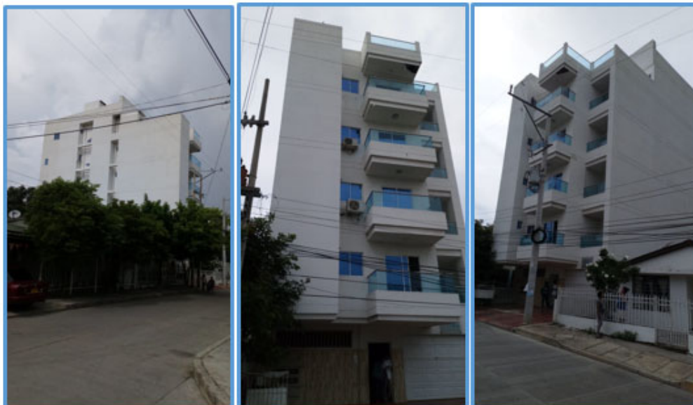
Fotografía 1. Edificio Villa May.
