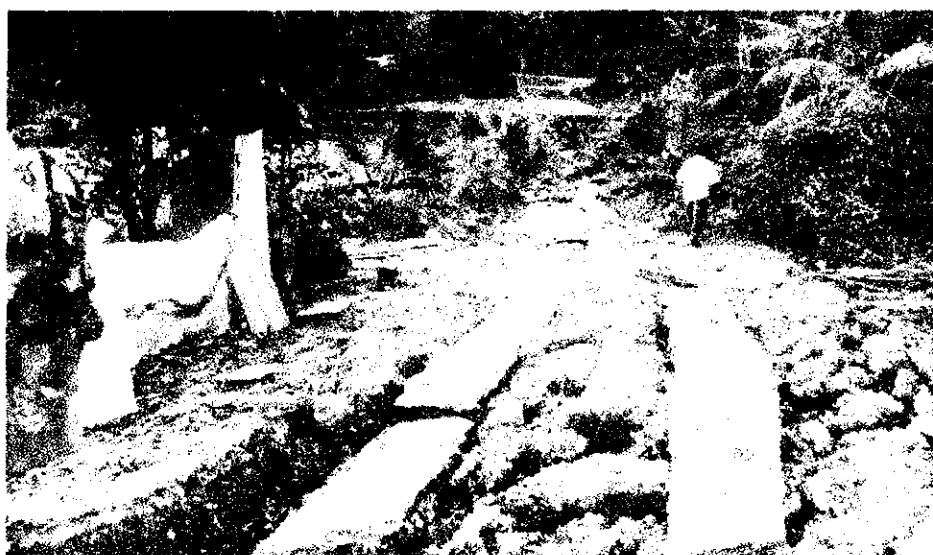
Figura 14. Vía de acceso destruida por el avance del deslizamiento.
