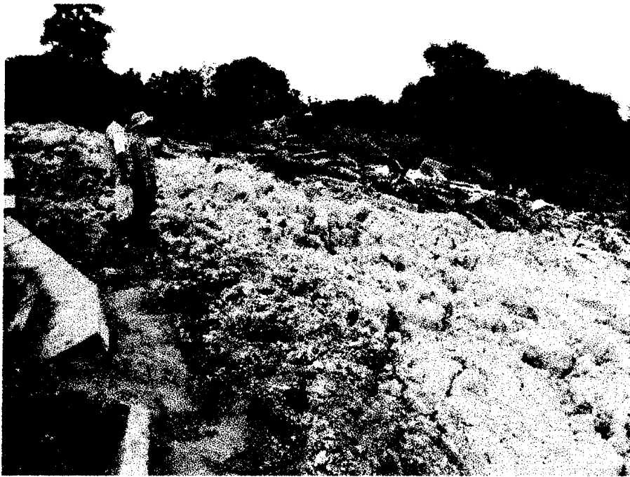
Figura 11. Material de relleno de la vía de acceso, desplazado por el deslizamiento. Obsérvese los escombros de una vivienda destruida.
