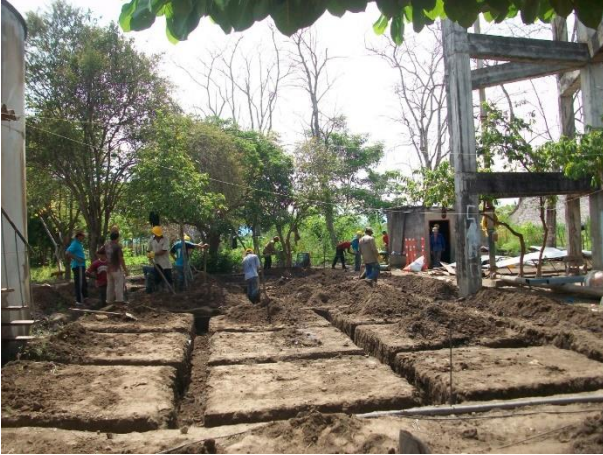
EXCAVACI6N CIMENTACI6N PLANTA
