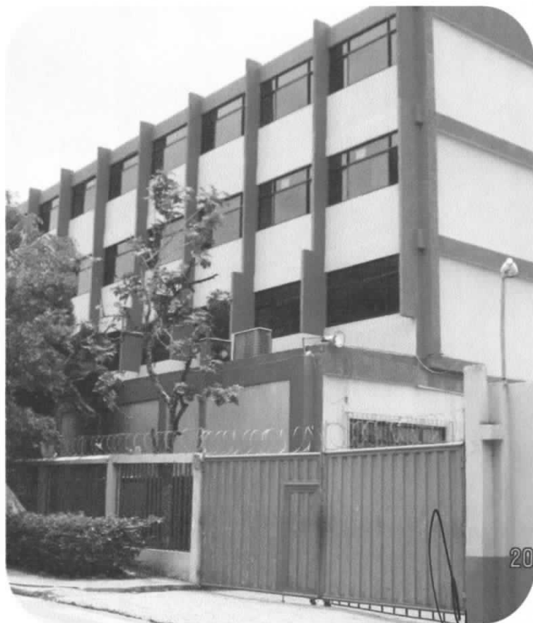
VISTA DEL BLOQUE DE SALONES Y ACCESO
