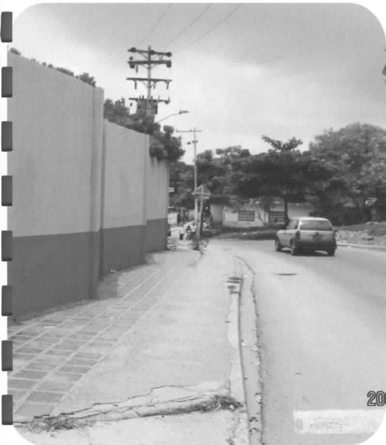
VISTA GENERAL EN EL ENTORNO AL
