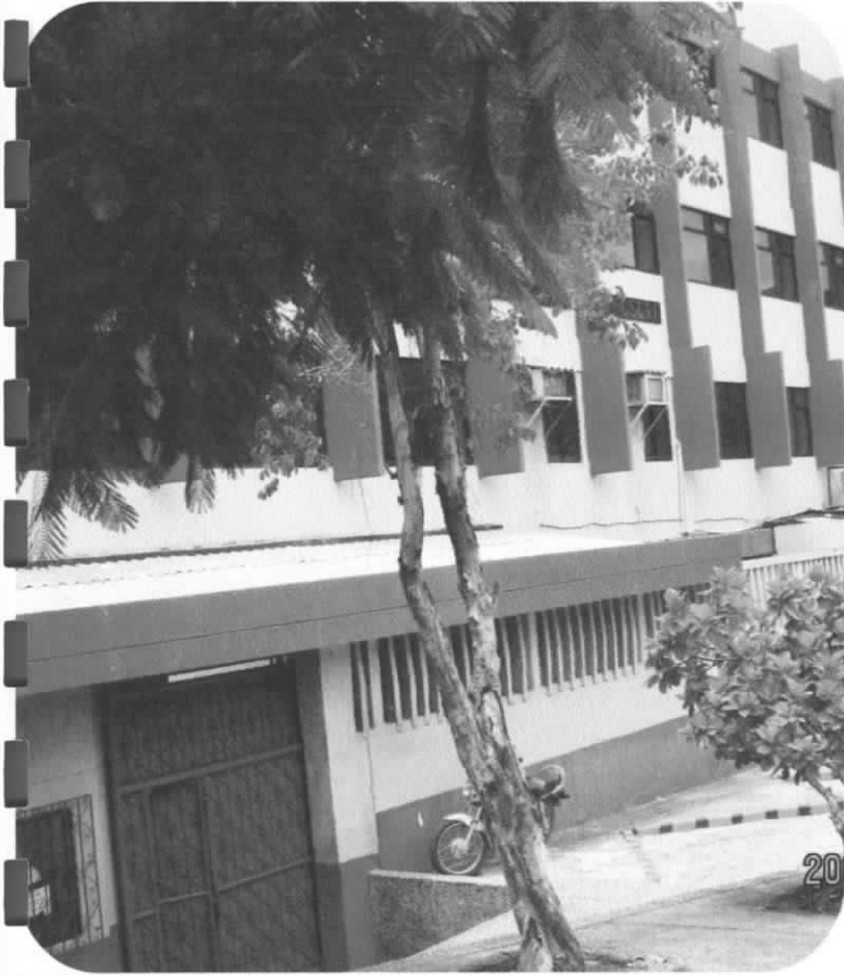
VISTA GENERAL DEL PREDIO EN ESTUDIO VISTA GENERAL DEL PREDIO EN ESTUDIO
