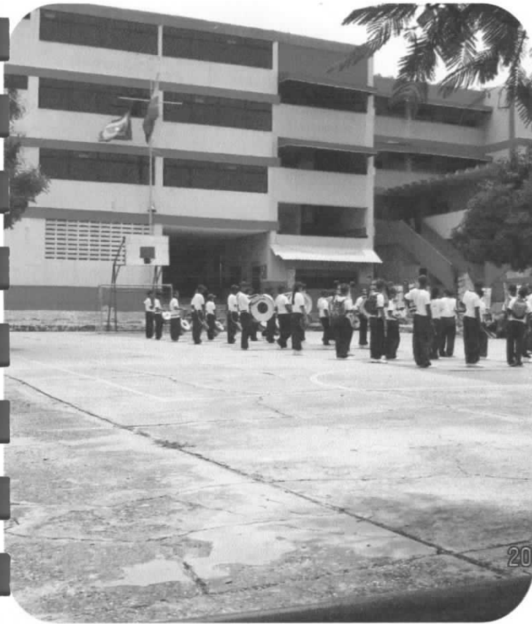
VISTA BLOQUE SALONES DE CLASE VISTA BLOQUE SALONES DE CLASE
