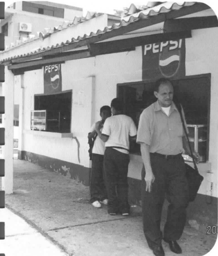
FACHADA AREA DE TIENDA FACHADA AREA DE TIENDA
