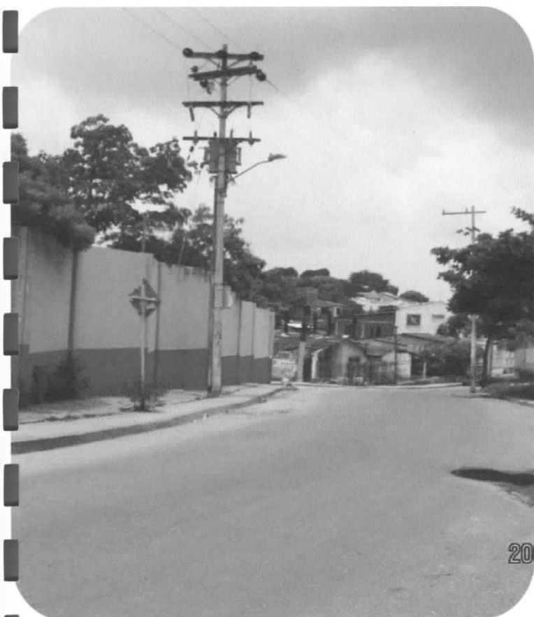
VISTA DEL COLEGIO Y SU ENTORNO VISTA DEL COLEGIO Y SU ENTORNO
