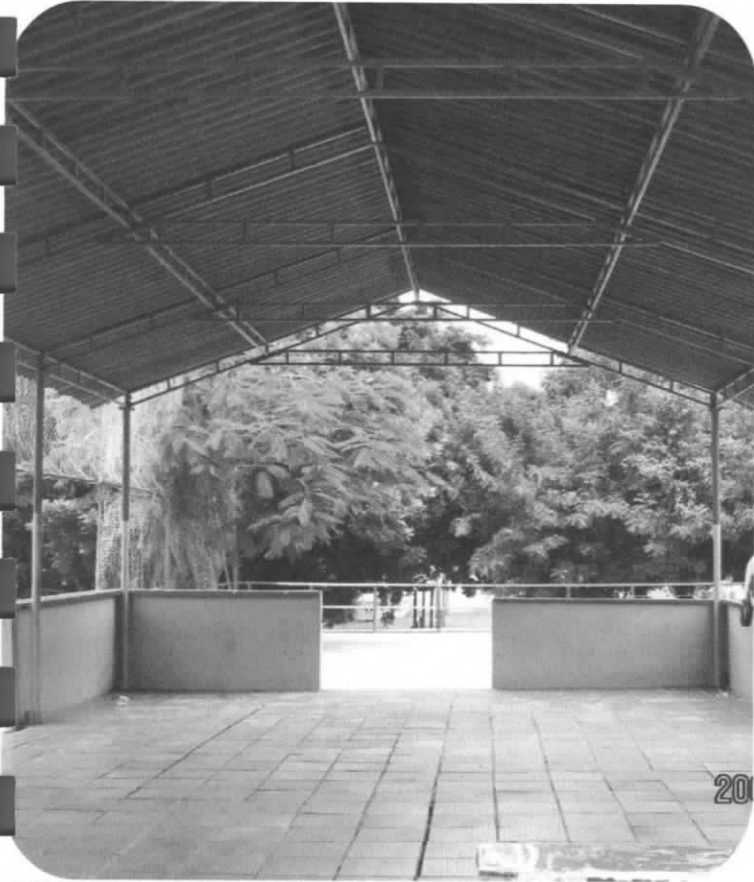
KIOSCO FRENTE A TIENDA Y CANCHA
