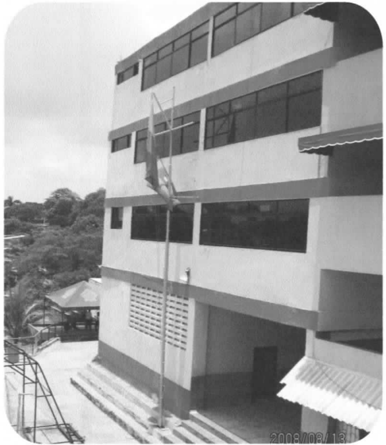
VISTA DEL BLOQUE DE SALONES DE
