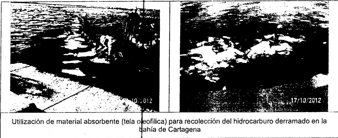
Utilización de material absorbente (tela oleofílica) para recolección del hidrocarburo derramado en la bahía de Cartagena
