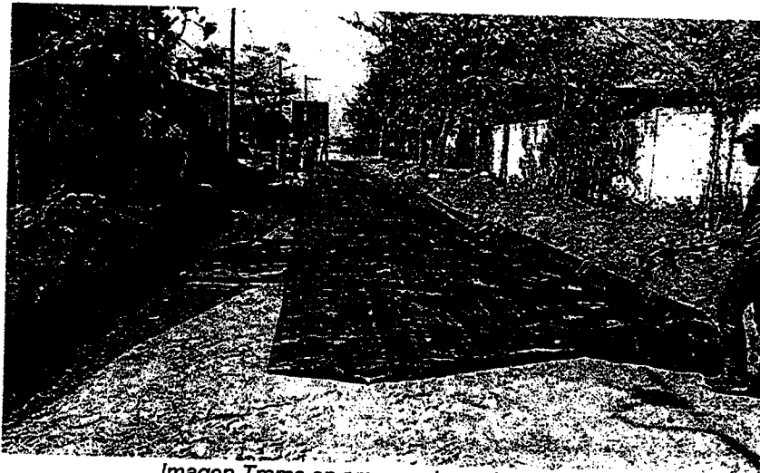
Imagen Tramo en proceso de pavimentación
