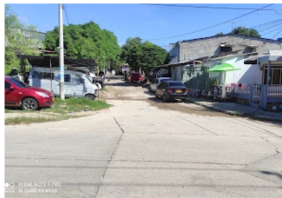
Estado de la carrera 67A con Calle 21
