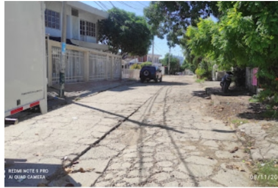
Condiciones actuales de la carrera 67A
