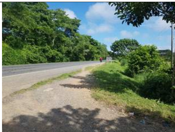
Carretera Planeta Rica – Montería.
