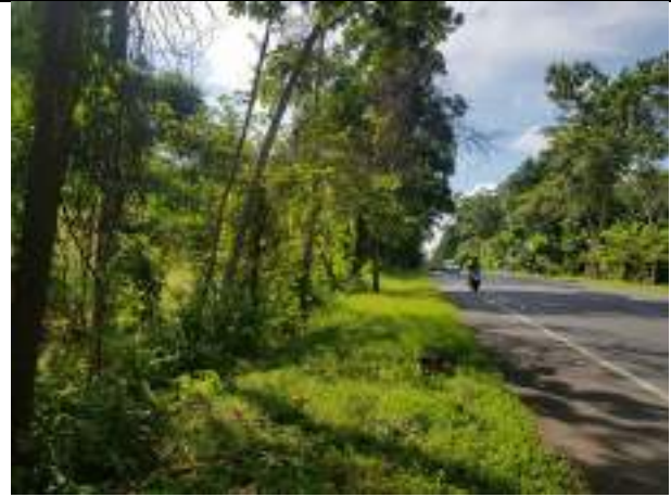
Carretera Planeta Rica – Montería.
