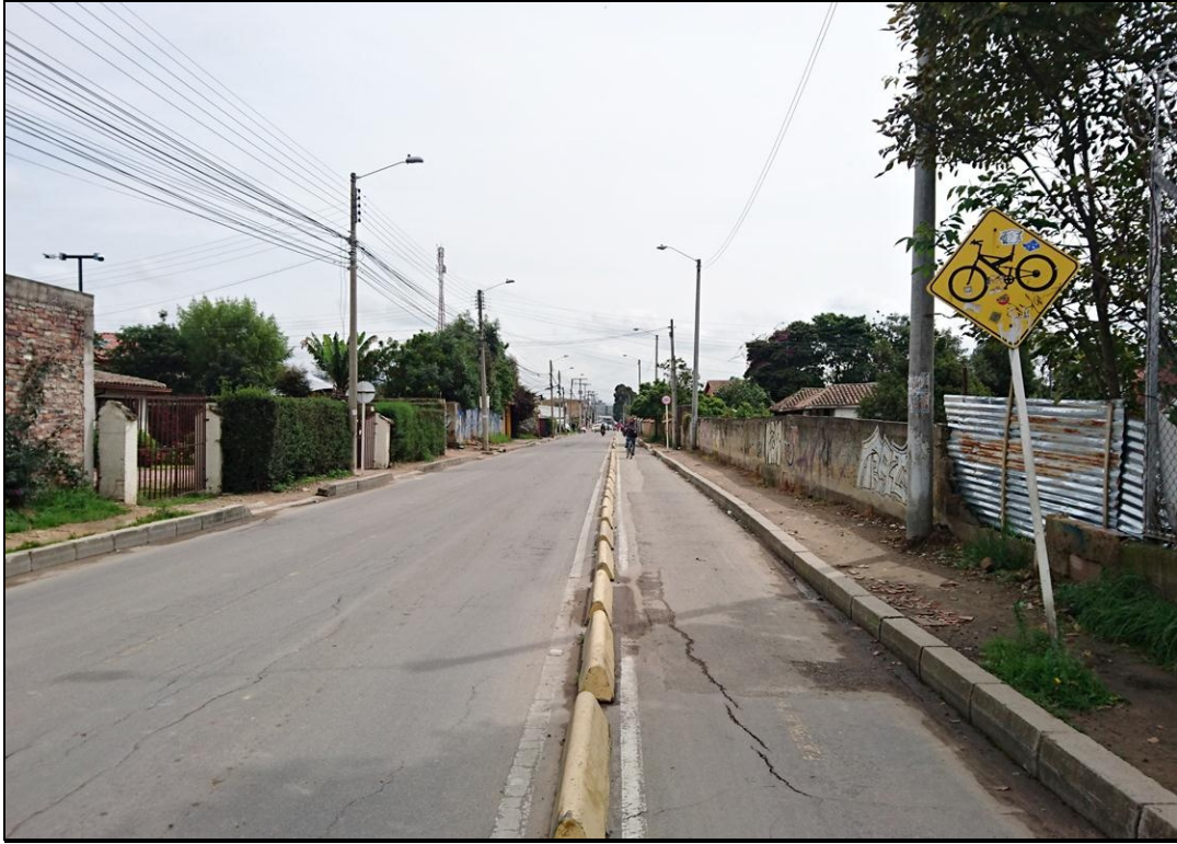
FOTO No. 03: Vista panorámica NORTE global de la vía pavimentada (KR 2 E) localización (sobre costado derecho) de la fachada del LOTE No. 3. (bloque pañetado y zinc)
