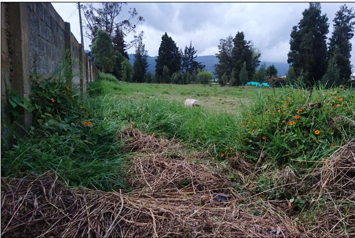
FOTO No. 06: Contemplación interior panorámica del LINDERO NORTE del predio LOTE No. 3 (muro en bloque y contrafuertes en ladrillo reforzado)
