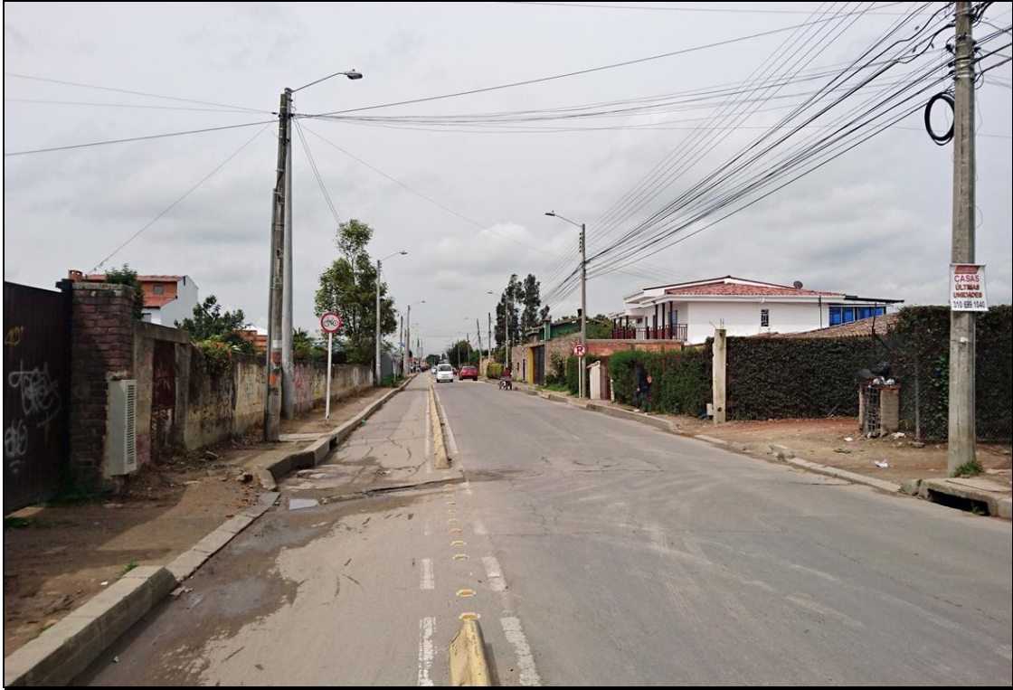
FOTO No. 01: Vista panorámica SUR global de la vía pavimentada ( KR 2 E) localización (sobre costado izquierdo) de la fachada del LOTE No. 3.
