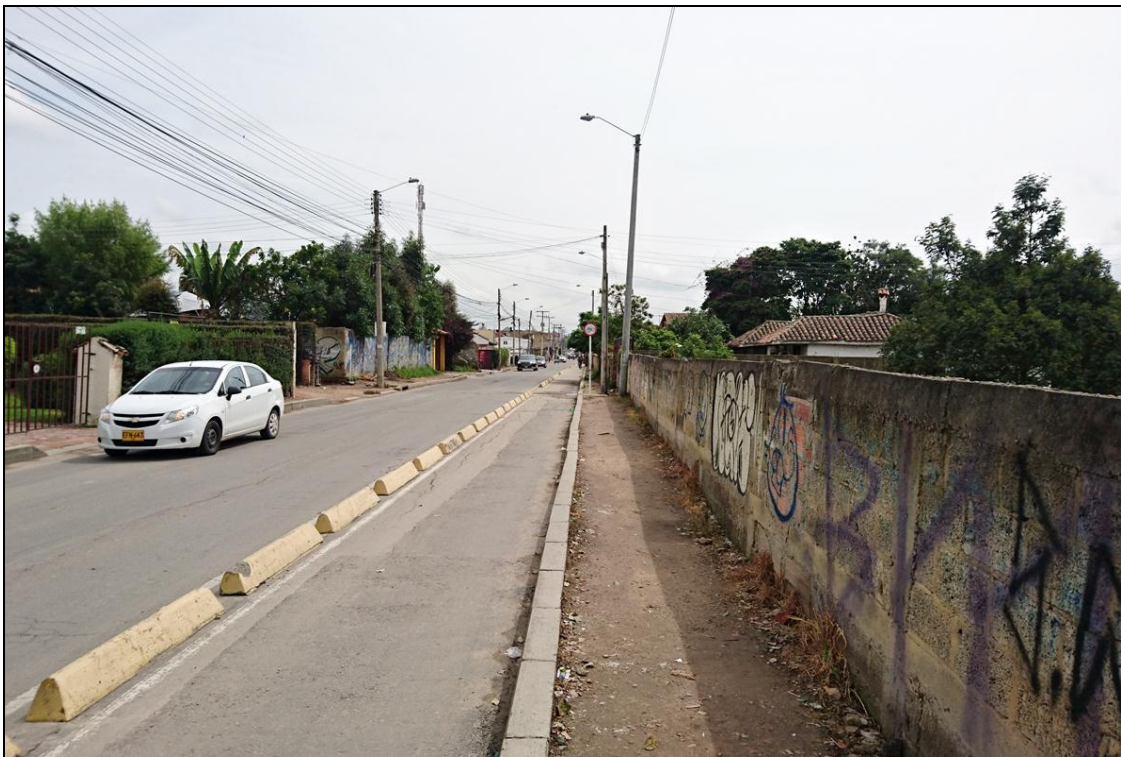
FOTO No. 02: Visión del muro en mampostería de bloque, que forma la fachada del Lote No. 3 sobre la KR 2 E
