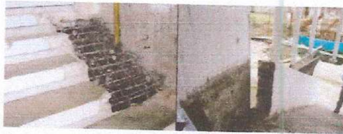
Fotografía 34. Escalera de acceso al coliseo
