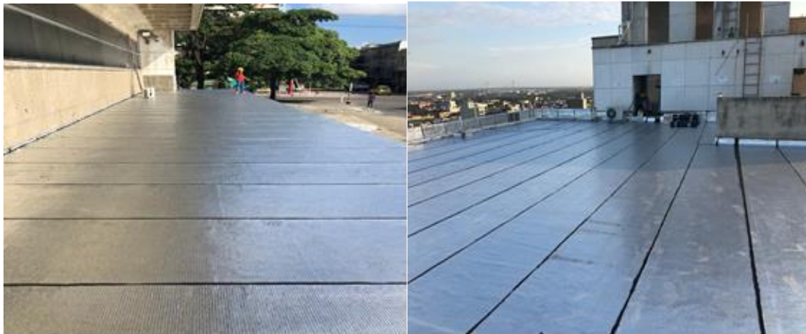
Imagen 3. Mantenimiento, reparación e impermeabilización de cubiertas Edificio Lara Bonilla
