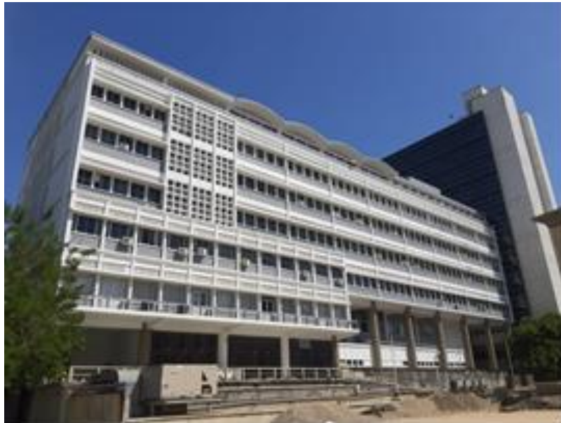
Imagen 2. Mantenimiento, reparación y pintura de la fachada del Edificio Centro Cívico
