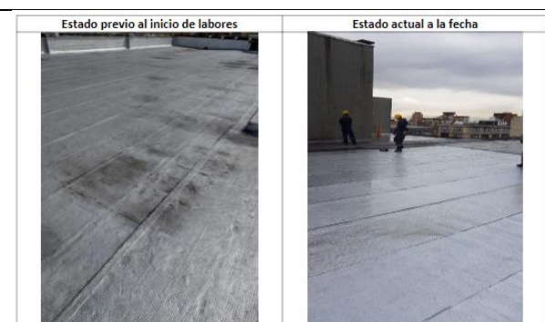
Estado de las obras
