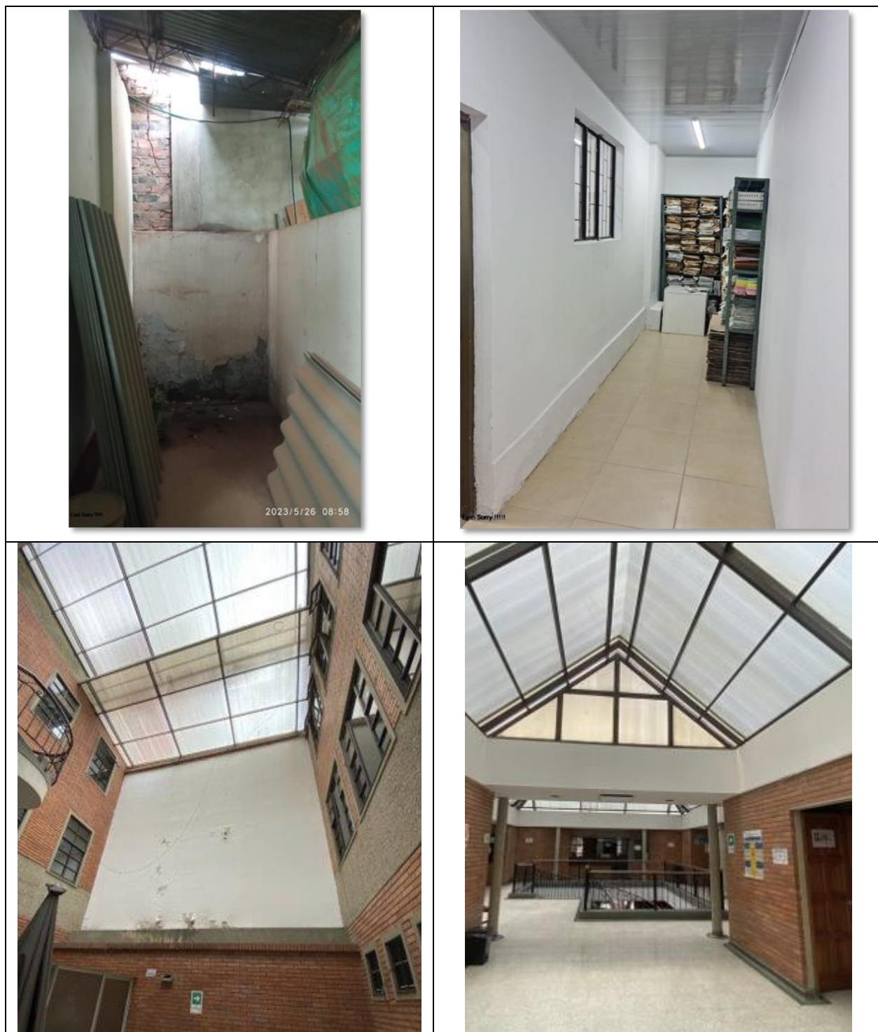
Imagen No.6. Registro fotográfico mejoramiento y mantenimiento de algunas sedes judiciales
