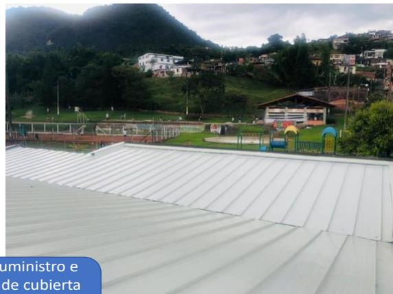
Obras de suministro e instalación de cubierta en teja tipo "Standing Seam" para el Palacio de Justicia de Riosucio
