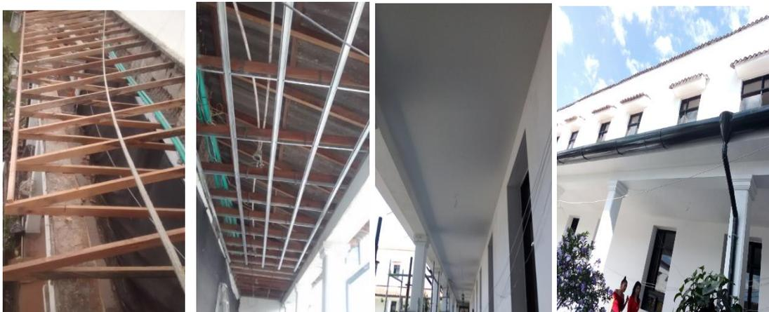
Instalación de cielo raso nuevo en los pasillos entre los dos patios, con instalación de luminarias LED:
