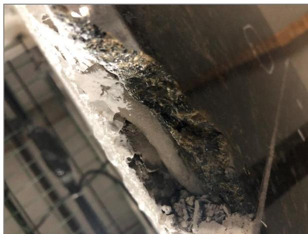
*Foto 1. Estado de las piedras de revestimiento de granito en acceso a ascensor. Edificio Centro Cívico.*
