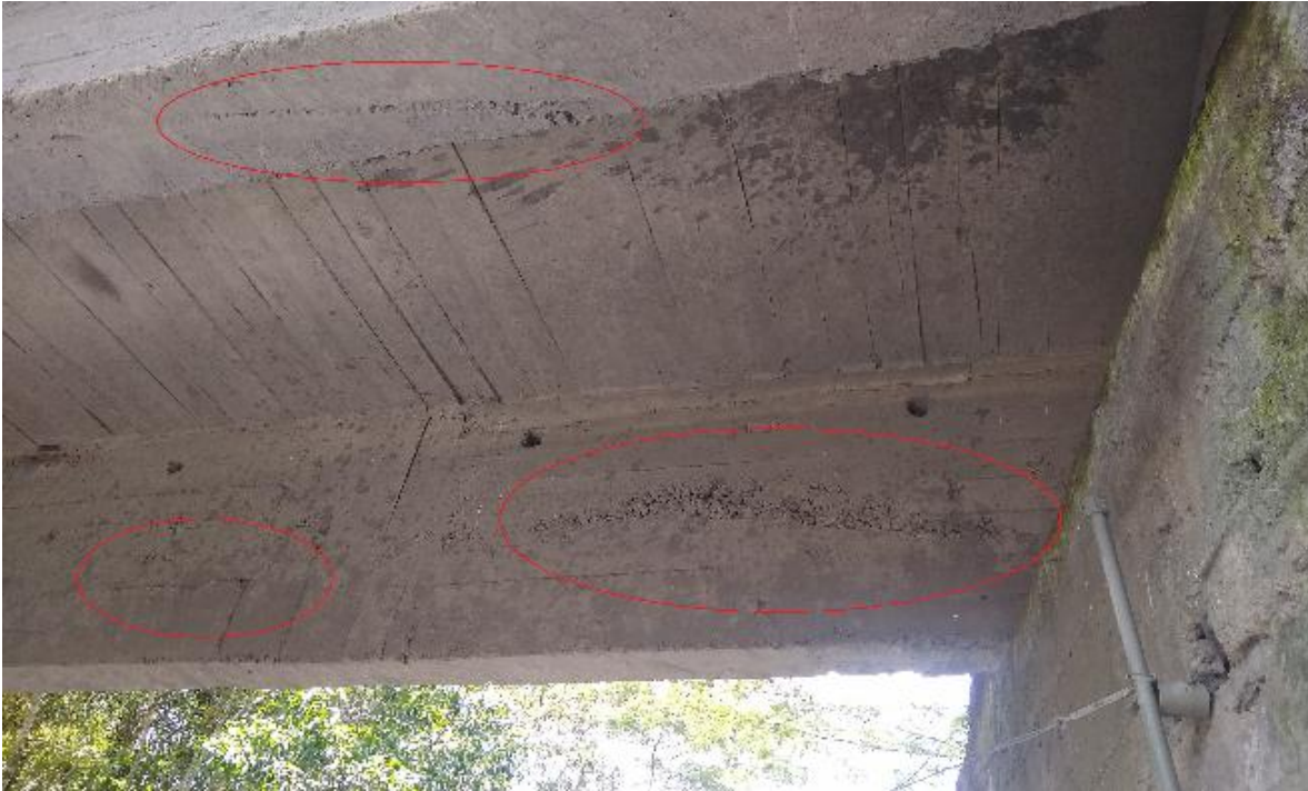
Foto No.13 Fallas en procesos constructivos hormigoneo en vigas principales.
