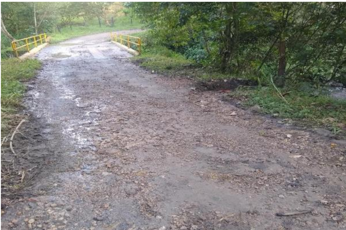
Foto No.3. Vía costado sur-occidental
