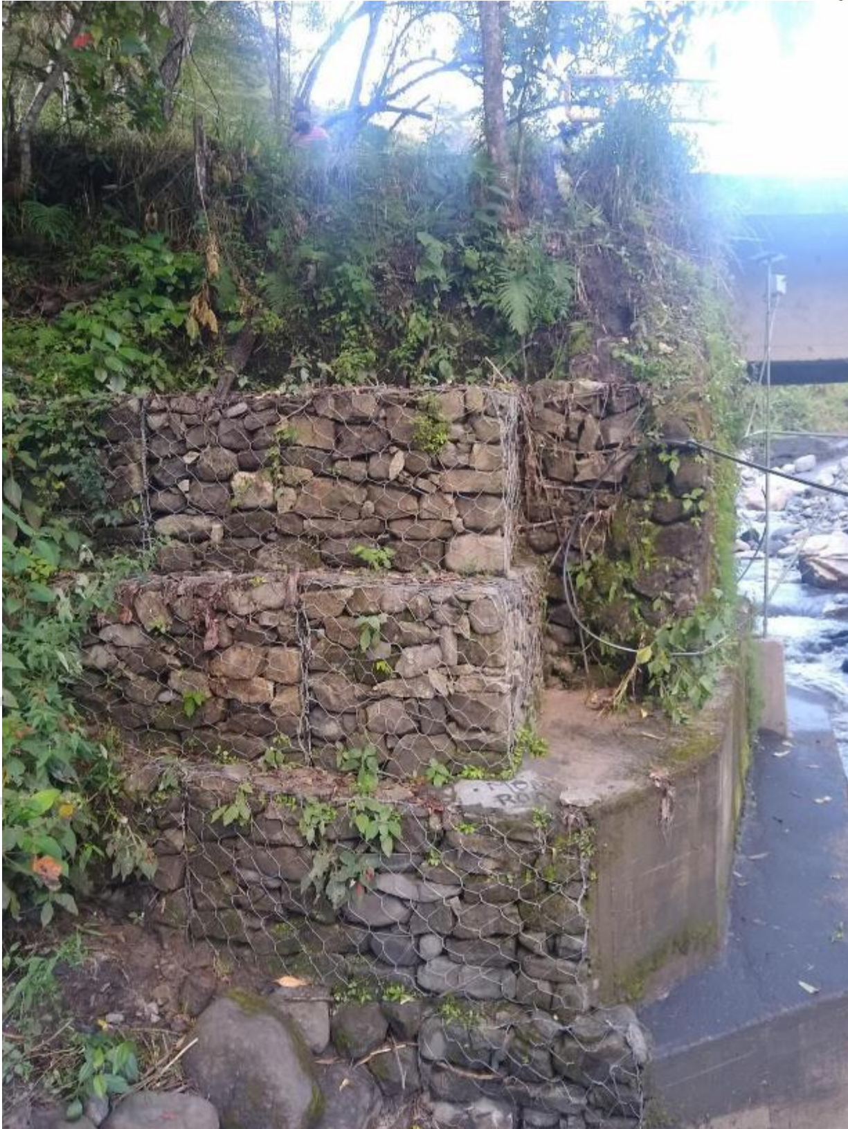
Foto No.8. Gaviones de protección en los estribos sin revestimiento.
