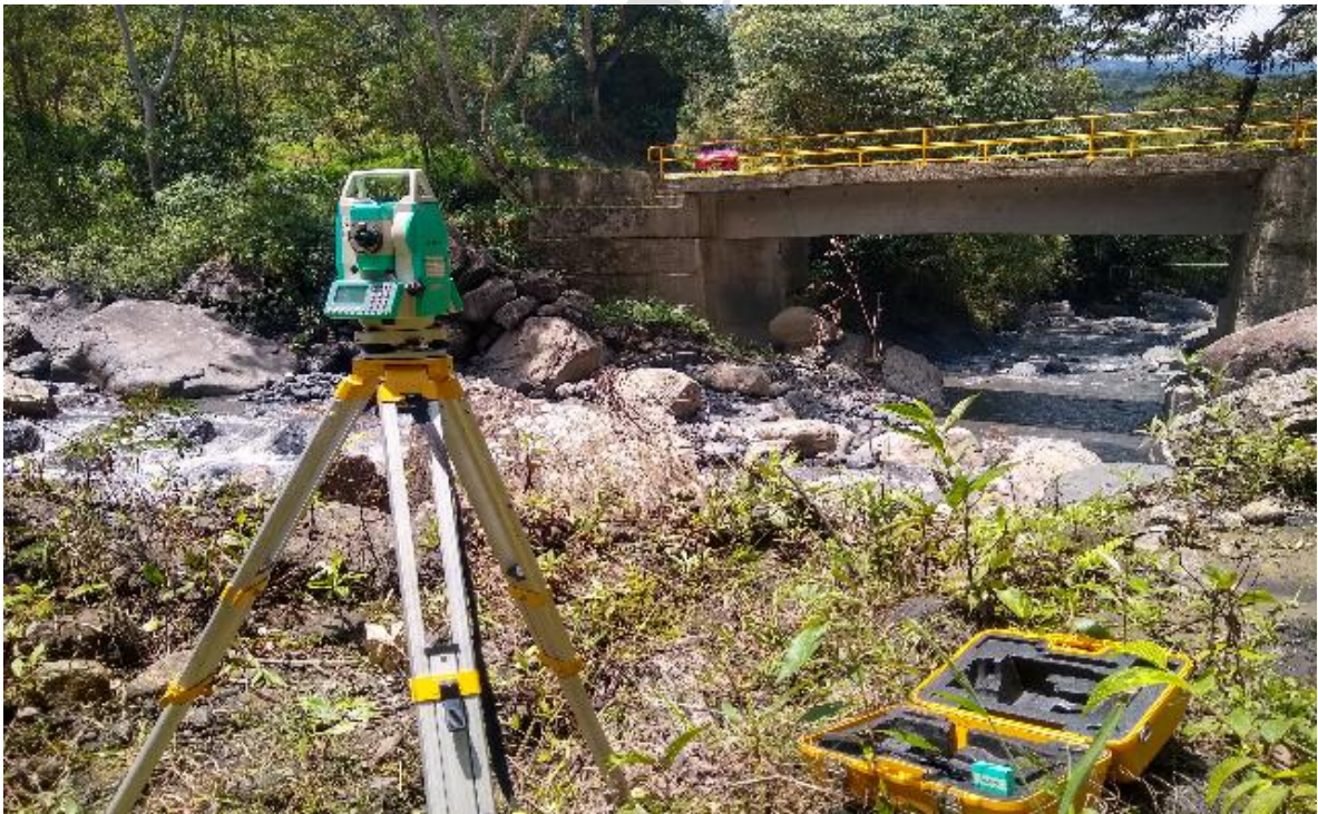
Foto No.12 control de verticalidad y horizontalidad parte inferior del puente.
