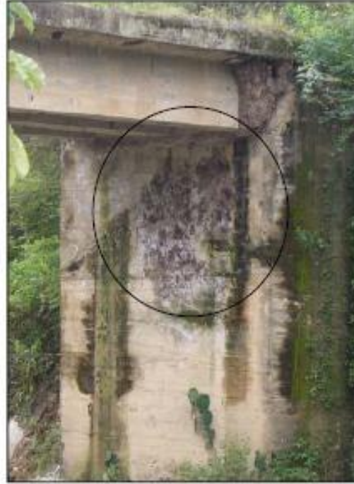
Imagen 7. Presencia de eflorescencias en el estribo del puente. Puente Río Melgar, Tolima.
