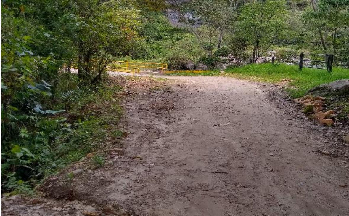
Foto No.9 Entrada sur del puente, diseño geométrico sin desarrollo óptimo.
