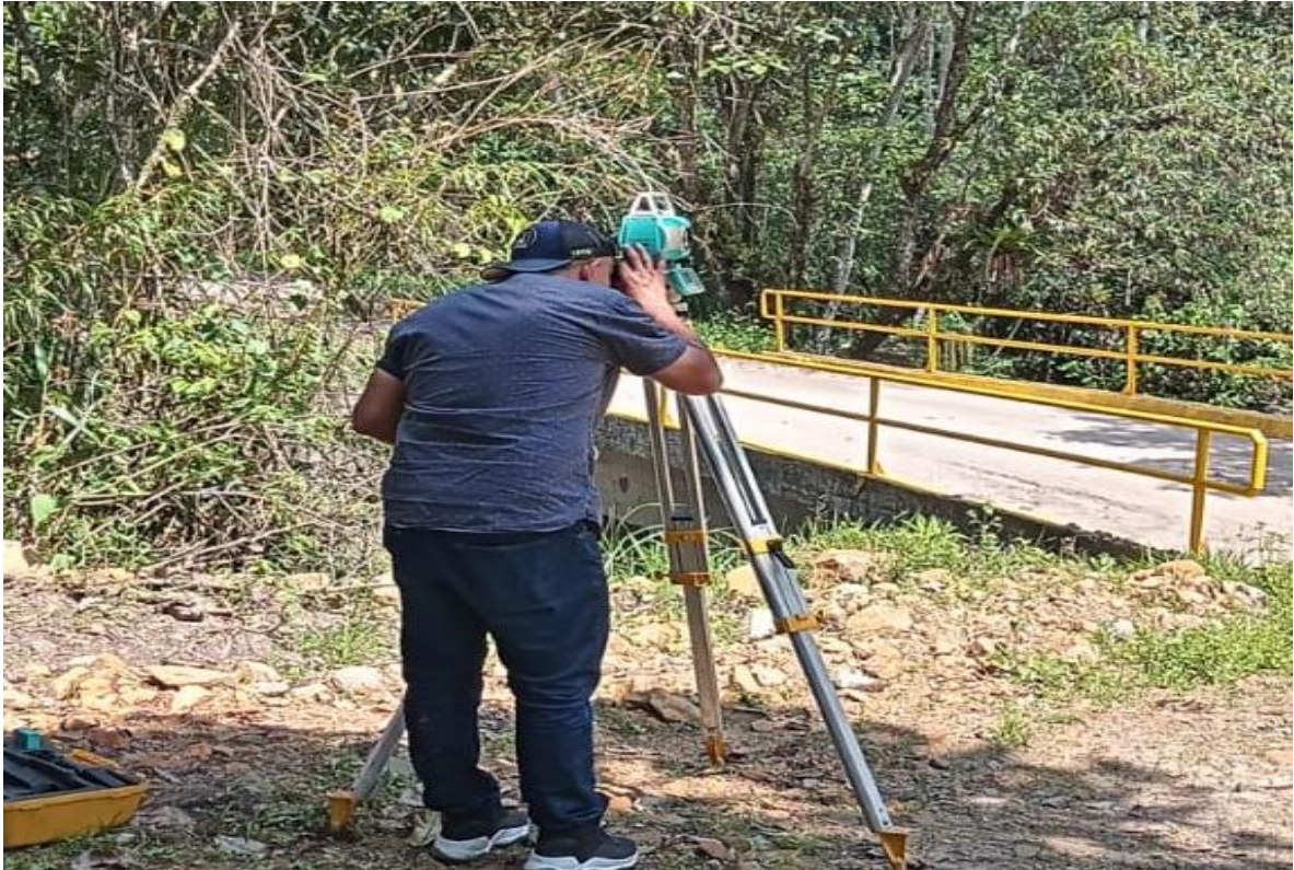
Foto No.11 control de verticalidad y horizontalidad parte superior del puente.
