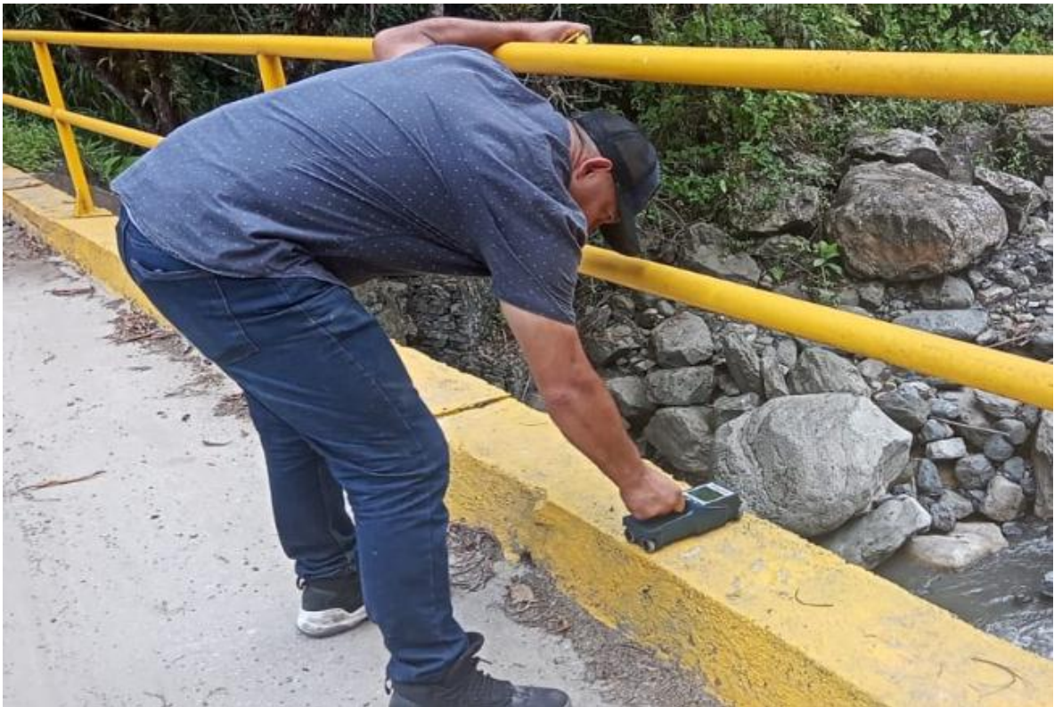
Foto No.16 ensayos de ferros scanner en tablero viga de baranda.
