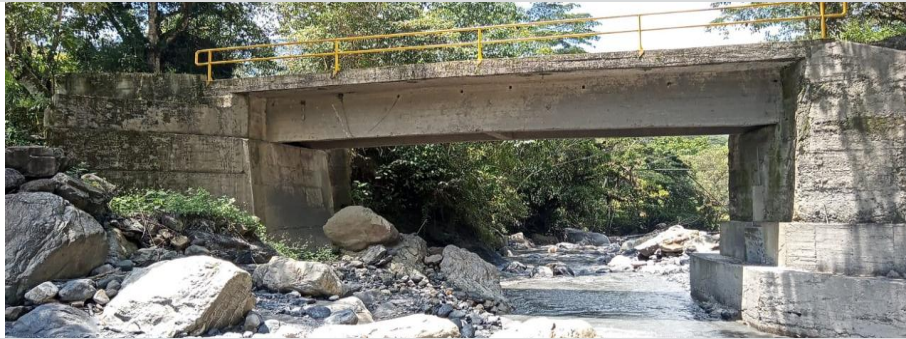
FOTOGRAFIA DE LA ALFECTACION
