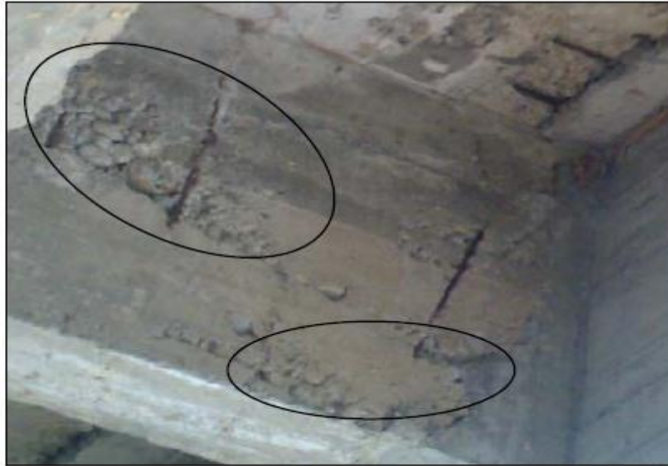
Imagen 2. Presencia de hormigueros en la viga cabezal. Puente Río Melgar, Tolima. Fuente: (INVIAS, 2006).
