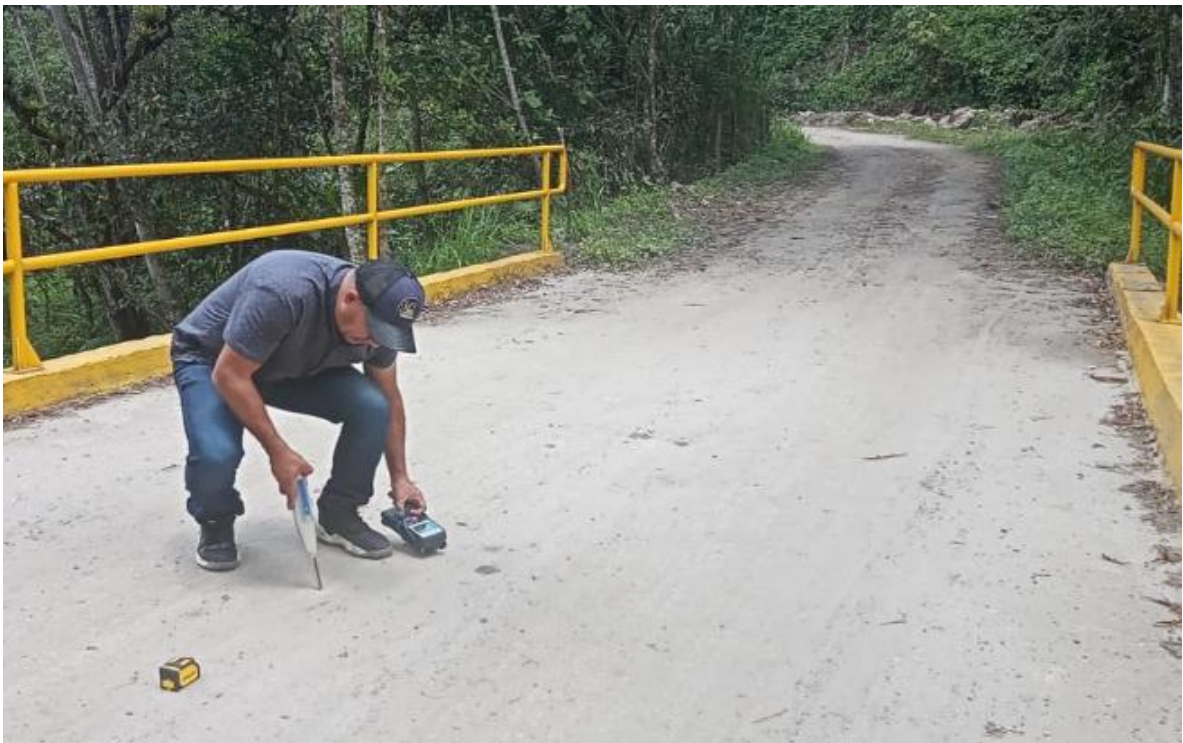
Foto No.18 ensayos de esclerometria en tablero o placa del puente.
