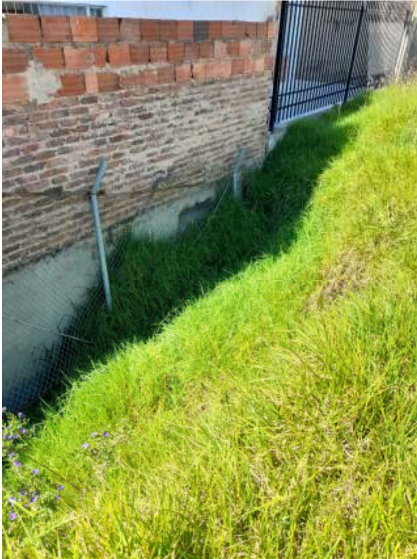
Pendiente pronunciada terreno anterior a la edificación
