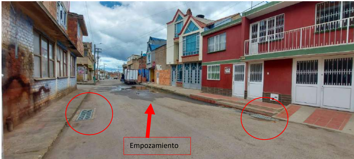
Fotografía 2: Presencia de dos sumideros de rejilla
