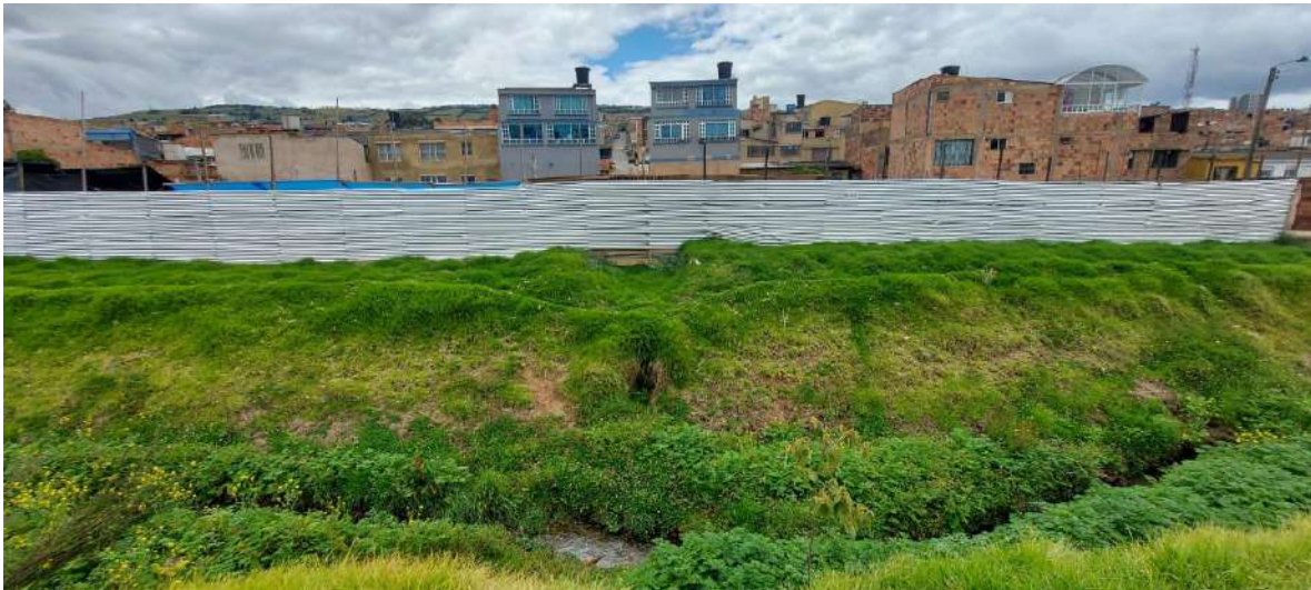
Fotografía 5: Contra fachada objeto de sellamiento en barrio Jordán
