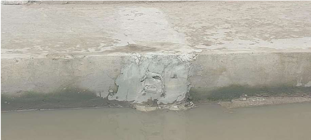
Fotografía 4: Taponamiento tubería paso de aguas pluviales
