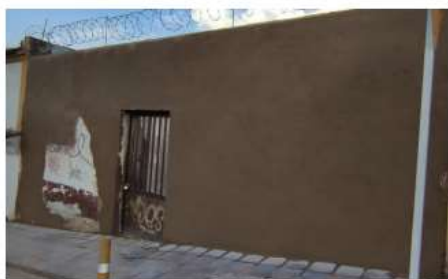
MEJORAMIENTO MURO FACHADA
