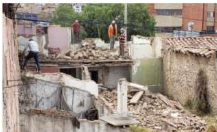
INICIO DEMOLICIÓN 22 DE FEBRERO
