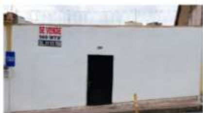
PINTURA Y ARREGLO FACHADA
