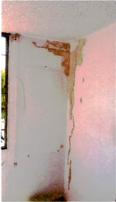
FOTOGRAFÍA No. 7 DETALLE RESANE Y PINTURA DE MUROS EN SALA-COMEDOR VIVIENDA No. 79
