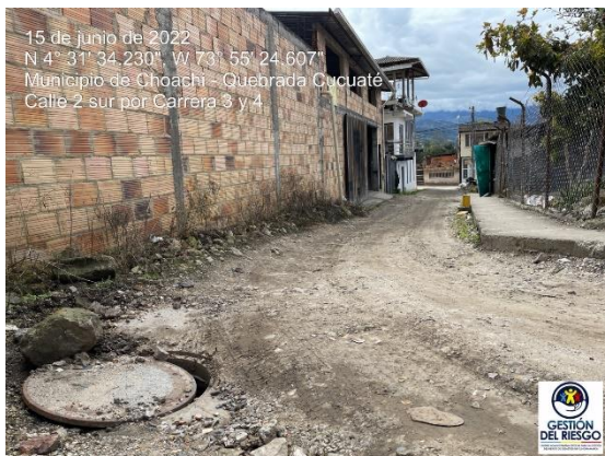
Fotografía 5 y 6. Se observa tramo de la Calle 2 SUR entre carrera 4 hacia carrera 3. Por donde se tiene un tramo de tubería de 36" de diámetro que conduce las aguas de la quebrada Cucuaté, se evidencia tapa de pozo de inspección.
