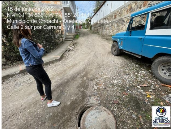
Fotografía 3 y 4. Se observa tramo de la Calle 2 SUR entre carrera 4 hacia carrera 3. Por donde se tiene un tramo de tubería de 36" de diámetro que conduce las aguas de la quebrada Cucuaté, se evidencia tapa de pozo de inspección.
