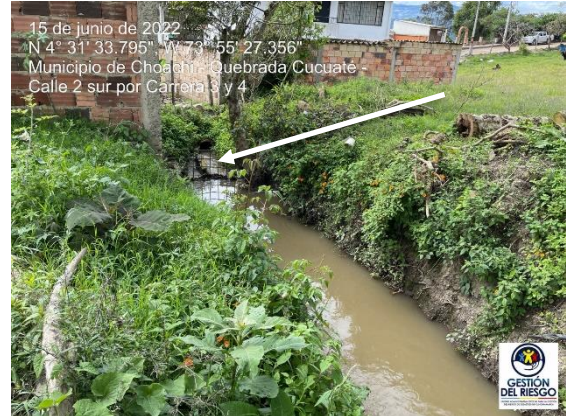
Fotografía 15 y 16. Se evidencia el discurrir de la fuente hídrica en zona de encole antes de cruzar la carrera 4 se aprecia en el cauce rejilla metálica para contención de sólidos.
