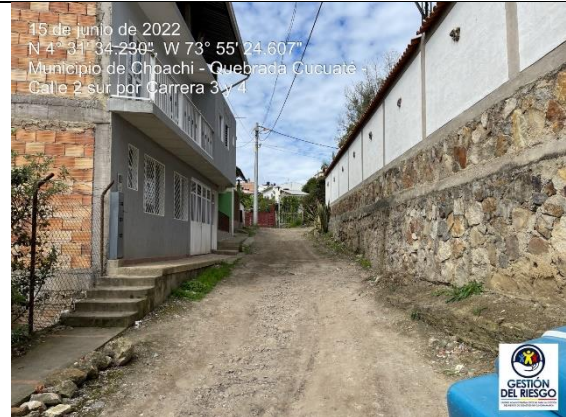
Fotografía 3 y 4. Se observa tramo de la Calle 2 SUR entre carrera 4 hacia carrera 3. Por donde se tiene un tramo de tubería de 36" de diámetro que conduce las aguas de la quebrada Cucuaté, se evidencia tapa de pozo de inspección.
