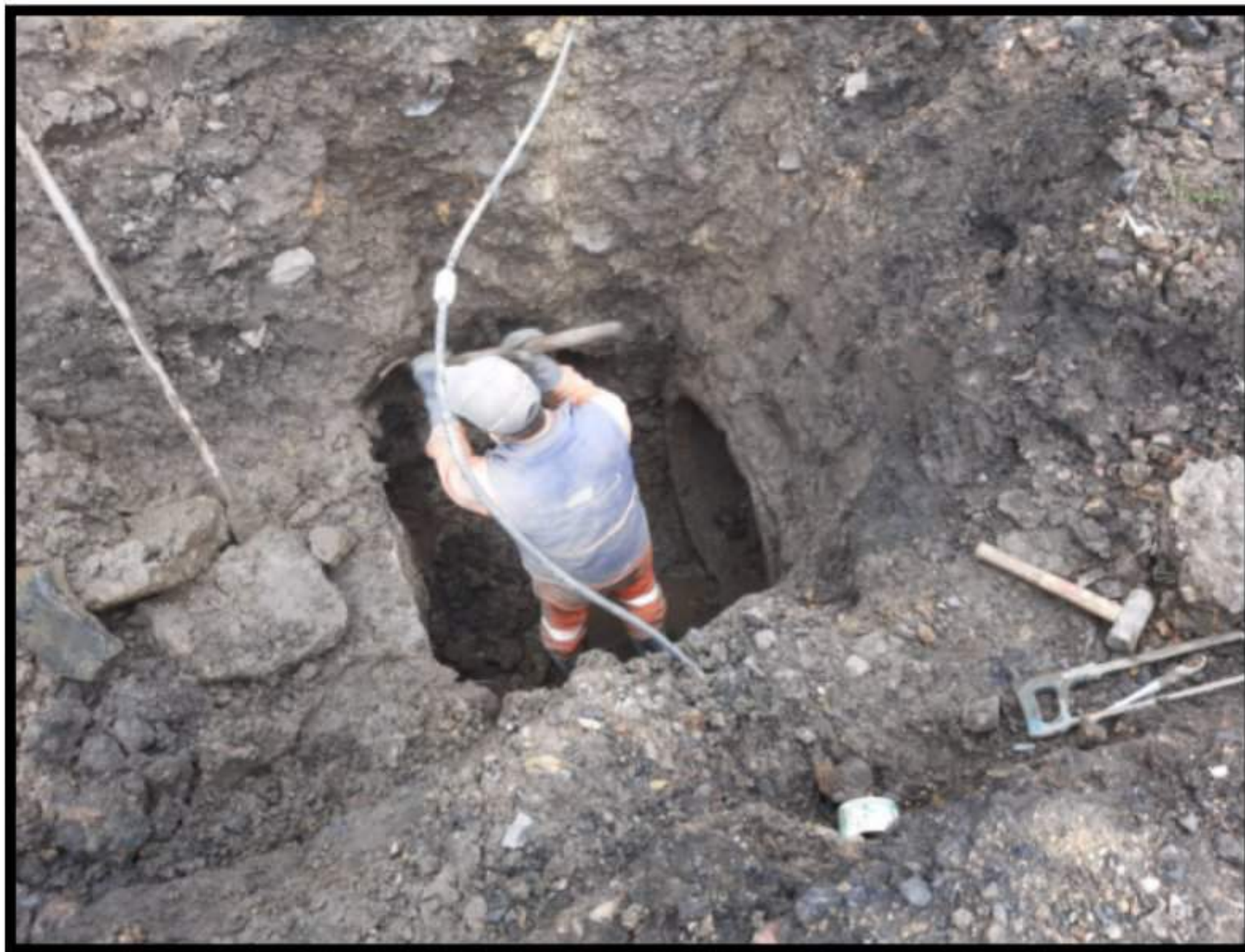
Imagen 3: restitución de red de 36" por paso de red domiciliaria.
