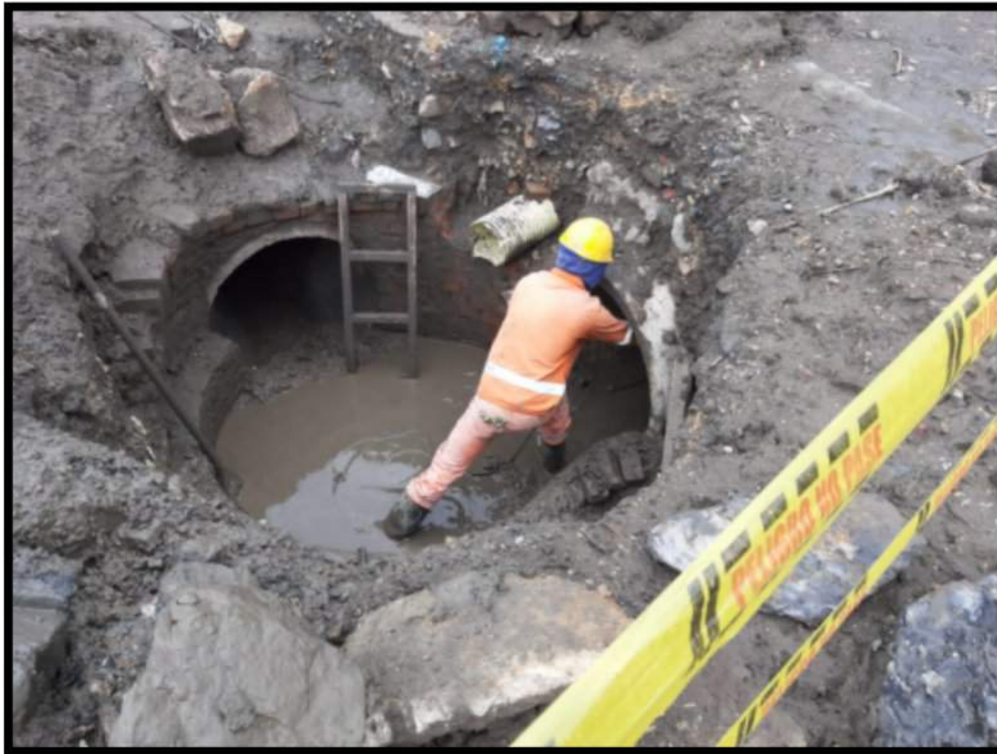
Imagen 4: Restitución estructura sobre calle 2 sur
