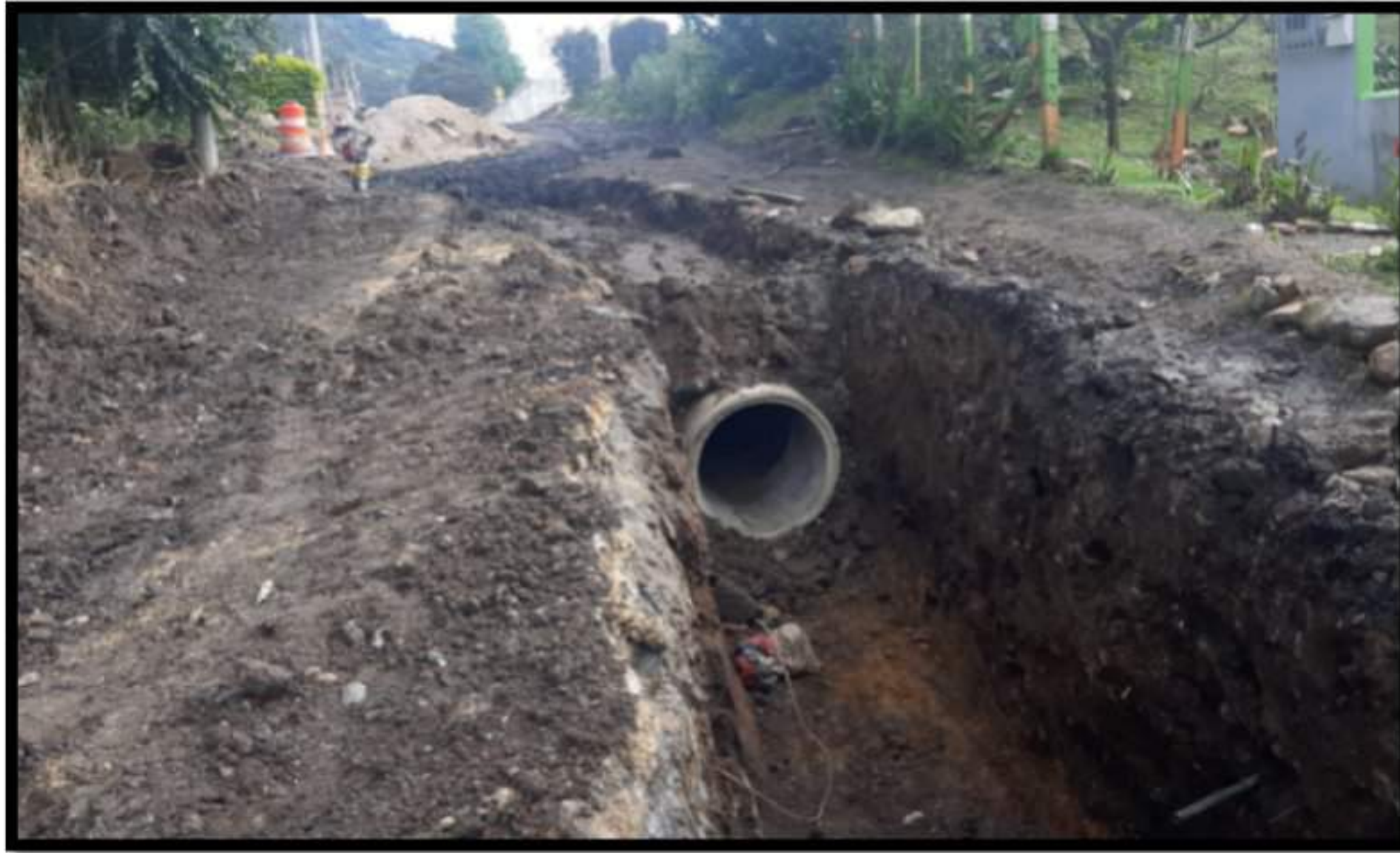
Imagen 2: Restitución de red afectada de 36" por paso de red pluvial de 42"
