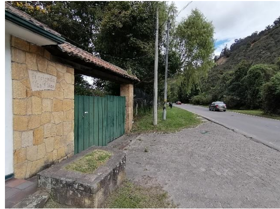
Fotografía 2. No se logra identificar el paso de la quebrada Pilas en el costado occidental de la Carrera 7
