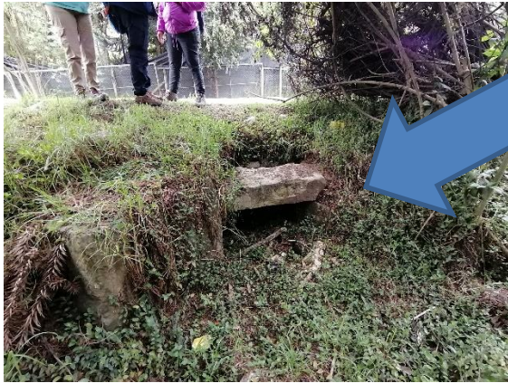
Fotografía 1. Estructura de paso Carrera 7 de la quebrada Pilas costado Oriental.
