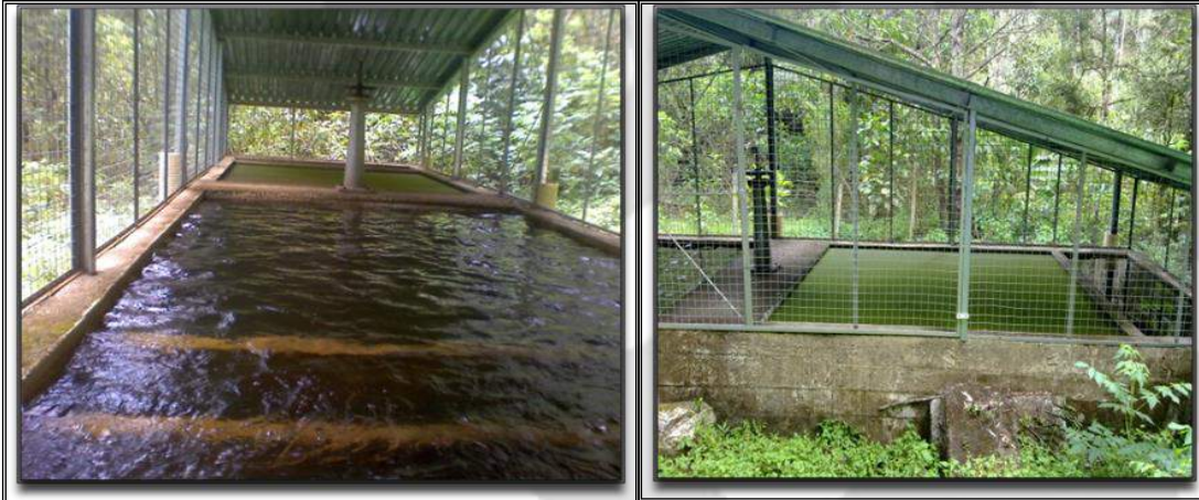
Foto No. 9 Desarenador
