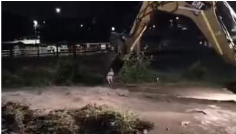
Imagen 11: Atención a la emergencia de inundación barrio San Luis
