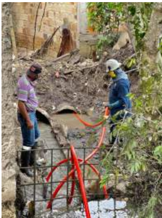
Imagen 20: La única alternativa para destapar las tuberías de canalización ilegal fue romper los tubos, (que quedaron rotos).
