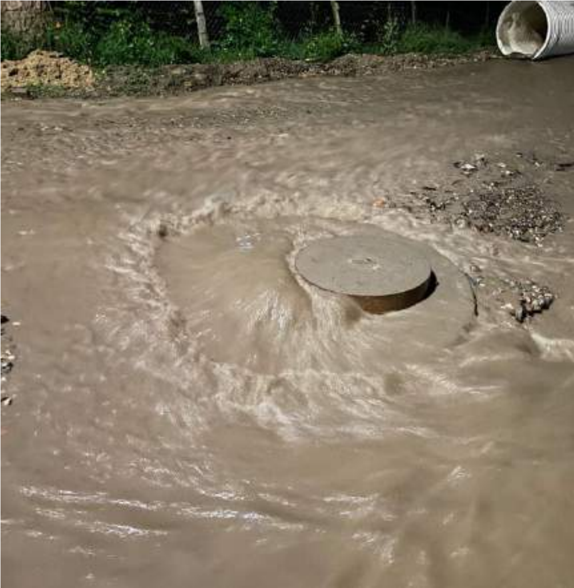
Imagen 16: La emergencia del 5 de mayo rebasó las alcantarillas
