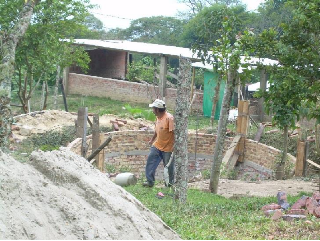
Construcción de pozo al lado de la casa, foto tomada en el año 2007.
