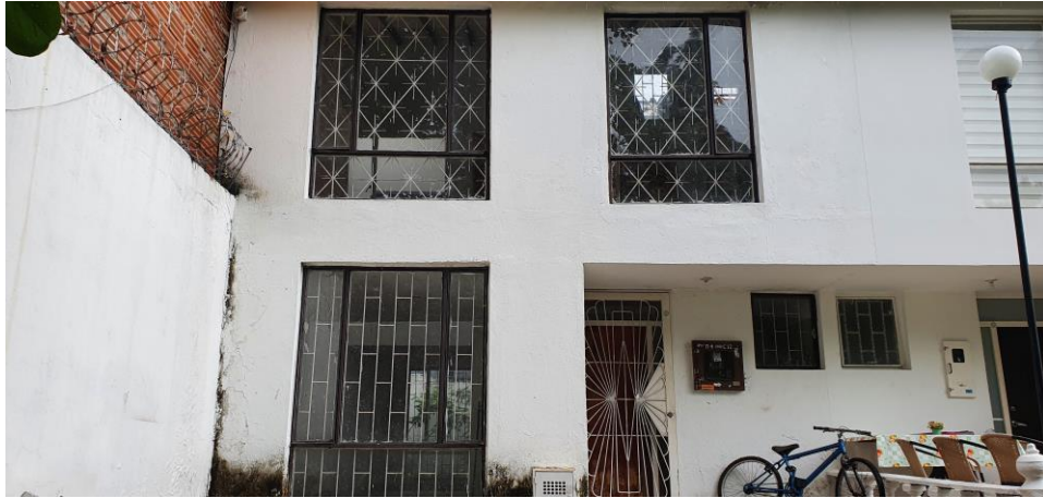
7. Fachada vivienda 12 mz 4
