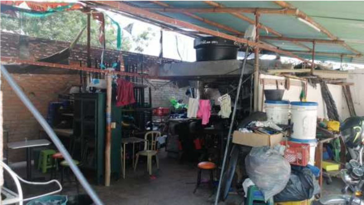
Construcción en guadua caedizo en la parte posterior, soportes metálicos cubierta enteja de zinc.
