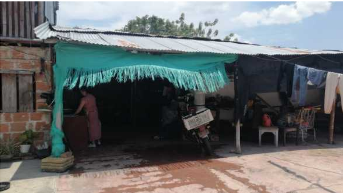
Construcción en guadua caedizo en la parte posterior, cubierta en teja de zinc.
