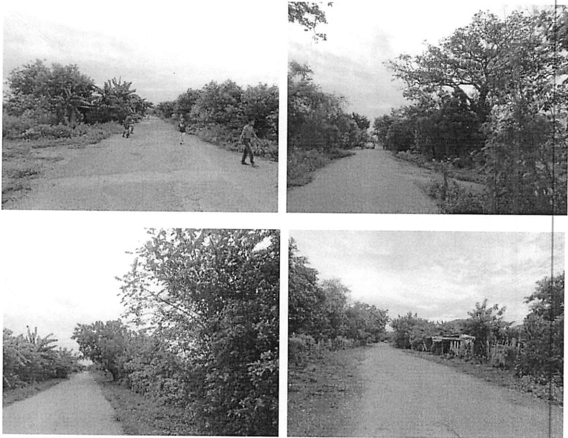
1. CARRETERA FLANDES – COELLO – VIA DE APROXIMACIÓN
