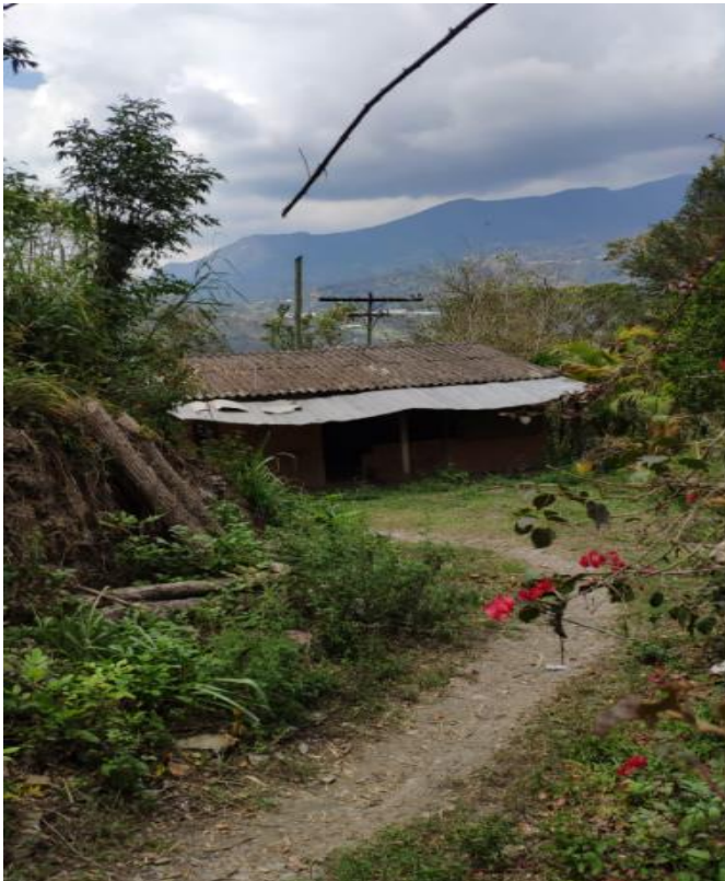
Imágenes No. 2. - Casa habitación de LUIS ANTONIO ALFEREZ RINCON
