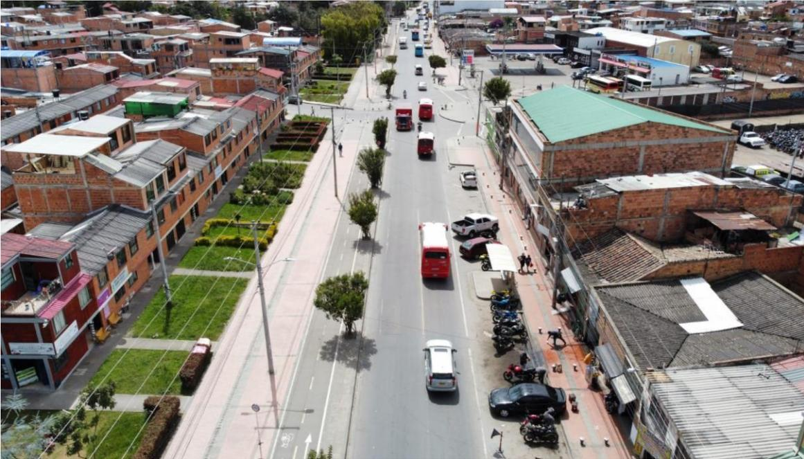
**FOTOGRAFIA 06 - Panorámica:** Fotografía tomada en sentido norte- sur, donde se observa el sentido de circulación de la carrera 7, cuyas características corresponden a una vía recta y plana, de una calzada en material asfalto, compuesta por dos carriles con doble sentido de circulación.
