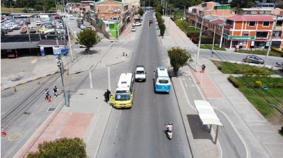
**FOTOGRAFIA 04** - Panorámica: Secuencia de la fotografía No 03, donde se observa que la carrera 7 con calle 14, en el municipio de Sibaté, donde La carrera 7 se trata de una vía recta y plana, de una calzada en material asfalto, compuesta por dos carriles con doble sentido de circulación.
