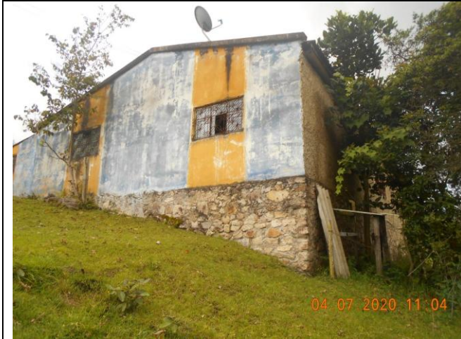
VISTA LATERAL Y RELLENO EN PIEDRA
