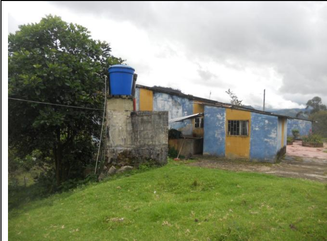
VISTA LATERAL Y TANQUE RESERVA
