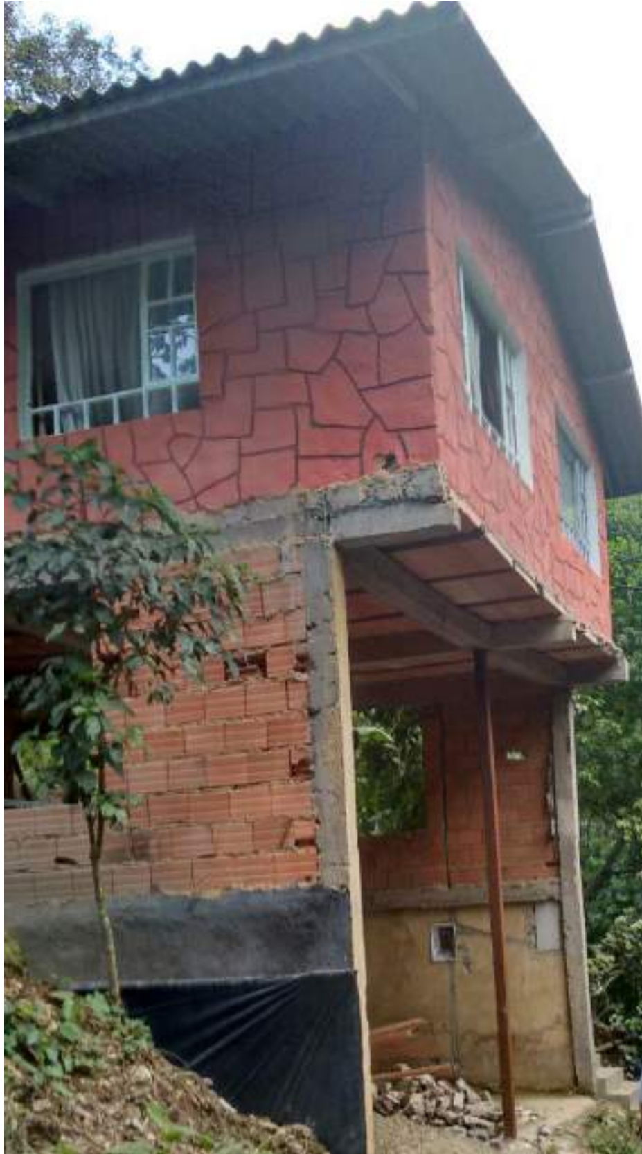
CASA PARTE BAJA EN CONSTRUCCIÓN
