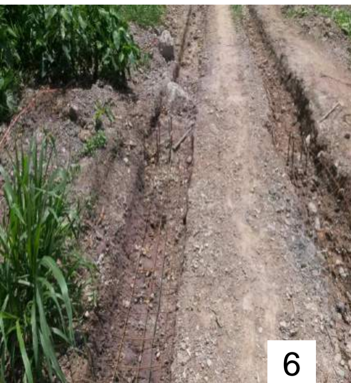
Placa huella del carretable que se está construyendo entre entrada fincas y nuevas viviendas
