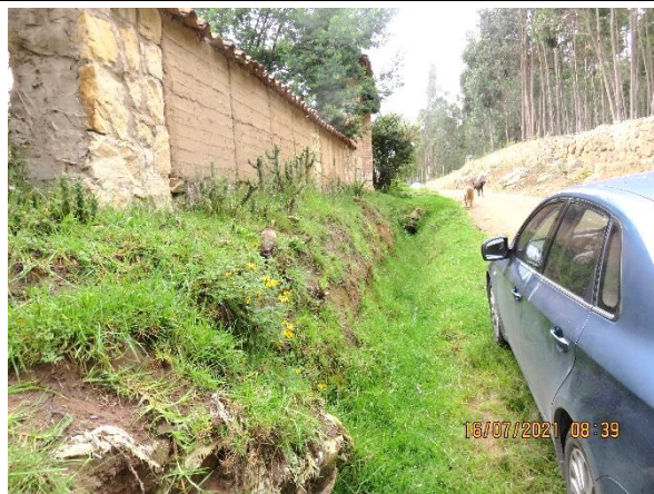
Muro cerramiento sobre el frente (parte exterior)
