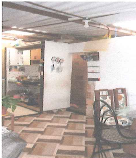
VISTA PISOS COCINA COMEDOR.
