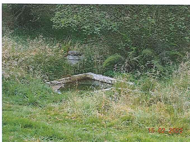
TANQUE DE RESERVA
