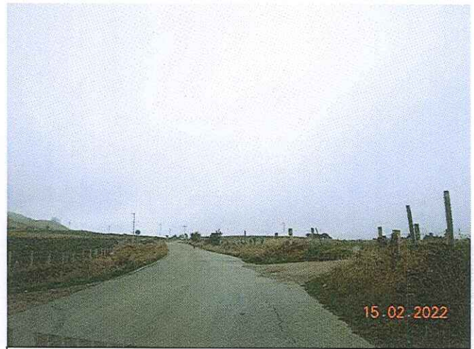
VÍA PRINCIPAL DE ACCESO
